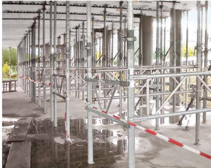
Figura 5: Cimbramento metálico em torres e escoras (Fonte: PERI, 2017)
