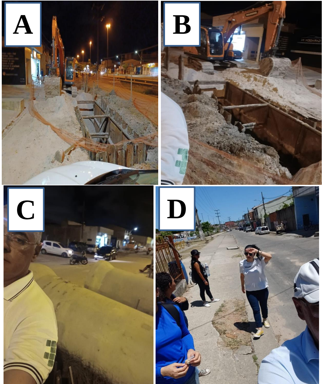
Figuras C, D – Execução Coletor principal – DN-800 mm / CA - Visita Técnica – Subsistema ERQ-Norte-Aracaju. Fonte: Fotos tiradas pelos alunos / Docente - Turma – CSA/IFS. Ano, Período 2022.2.
