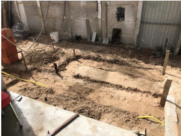
Figura 10. Fase de contrapiso.
