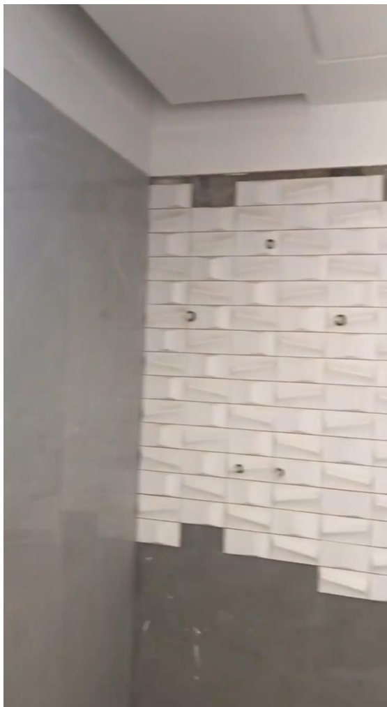
Figura 18. Remoção dos revestimentos nas paredes.
