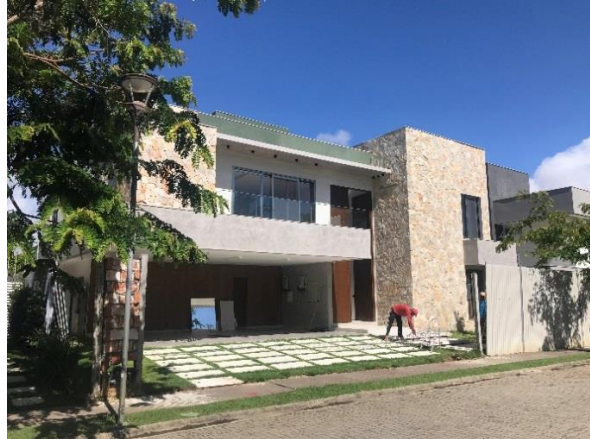
Figura 11. Acabamentos finais da obra.
