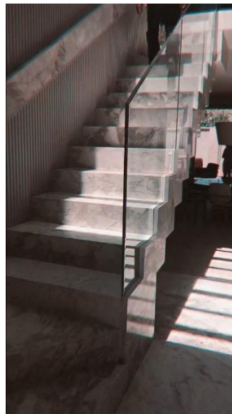
Figura 15. Finalização do revestimento na escada.
