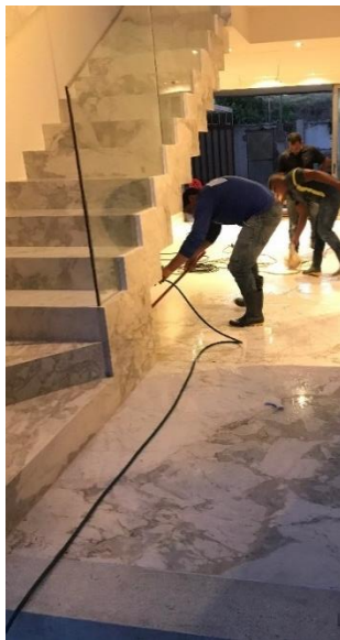
Figura 14. Polimento do mármore na escada.
