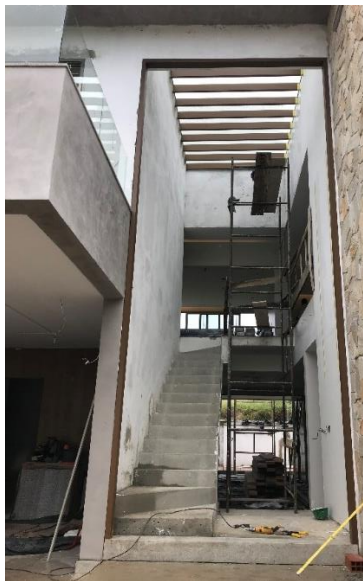
Figura 13. Etapa inicial do revestimento na escada.
