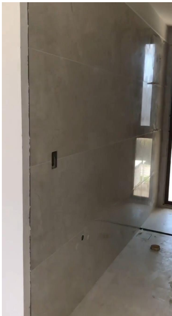
Figura 19. Reassentamento dos novos revestimentos.
