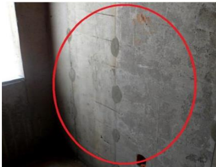
Figura 8 - Armadura exposta
