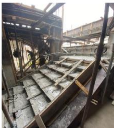
Figura 24 - Fôrmas utilizadas no canteiro
