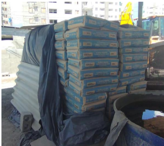
Foto 7 – Armazenamento do cimento
