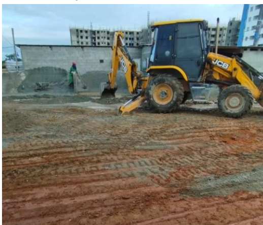
Foto 14 – Correção do caimento da área das baias
