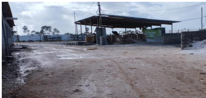
Foto 13 - Caimento da área das baías
