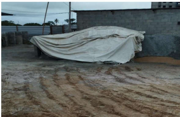
Foto 12 – Cobertura dos agregados com lona
