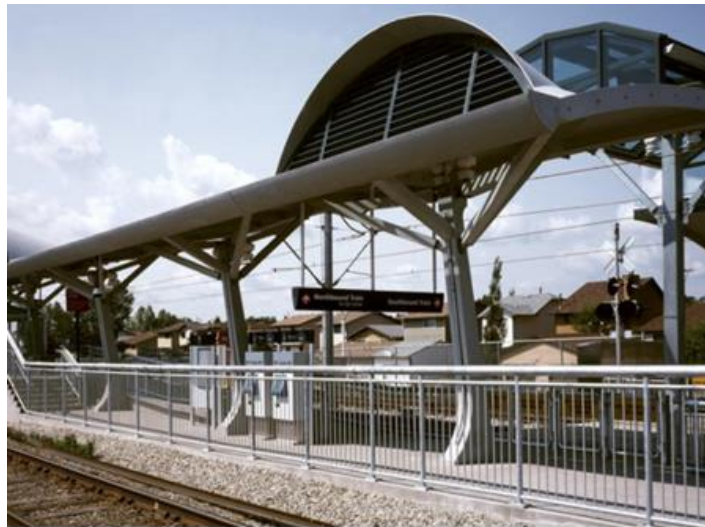
Figura 8 – Estação de VLT de Shawnessy: (a) Estação pronta; (b) estruturas brancas em CPR
