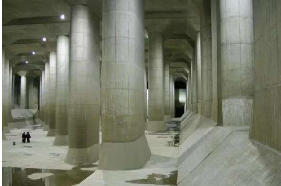
Figura 06 - Sistema de combate à enchente, “G Cans”, da cidade de Tóquio-JA
