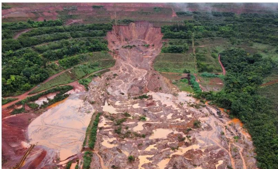
Figura 18 - Processo de ruptura por deslizamento
