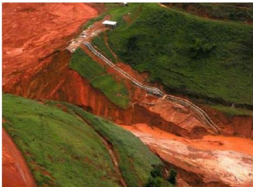
Figura 23 - Vista da barragem de rejeitos após a ruptura
