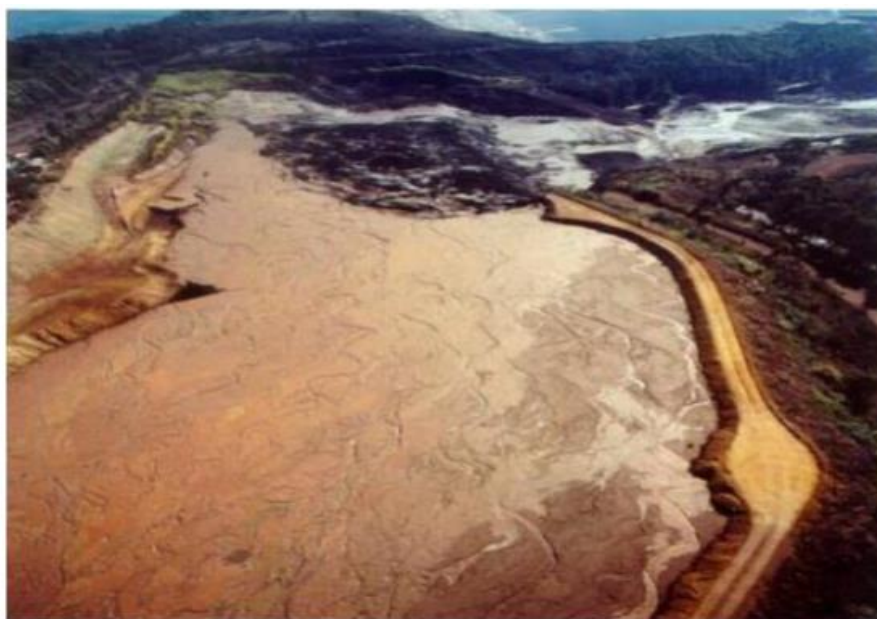
Figura 21 - Vista aérea da barragem de rejeitos da mineração Rio Verde após a ruptura
