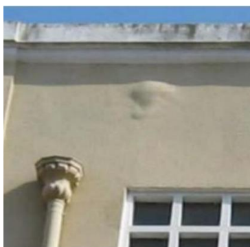
Figura 23 – Da esquerda para a direita, exemplos de destacamento, deformação e lacunas
