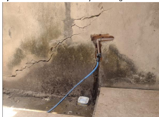
Figura 61 – Manchas umidade encontradas na inspeção
