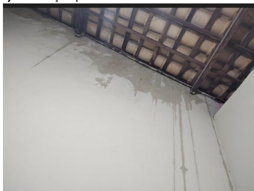
Figura 61 – Manchas umidade encontradas na inspeção
