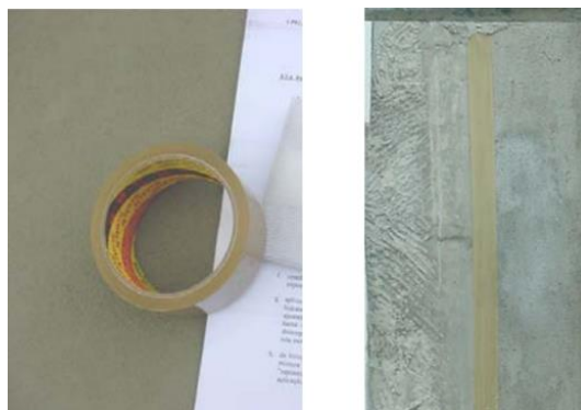
Figura 39 – Dessolidarização com fita de polipropileno aplicada sobre base regularizada com argamassa de cimento e areia.
