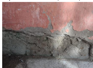
c) – Destacamento (casa 12)
