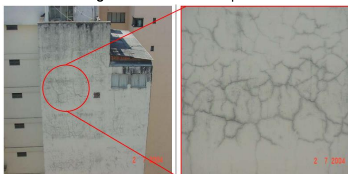
Figura 20 – Fissuras mapeadas
