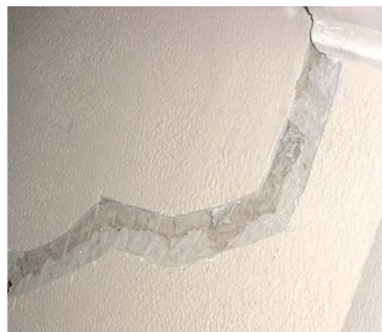
Figura 36 – Abertura de sulco retangular ao longo da fissura de 5 cm de largura por 5 mm de profundidade, centralizada em relação à abertura.
