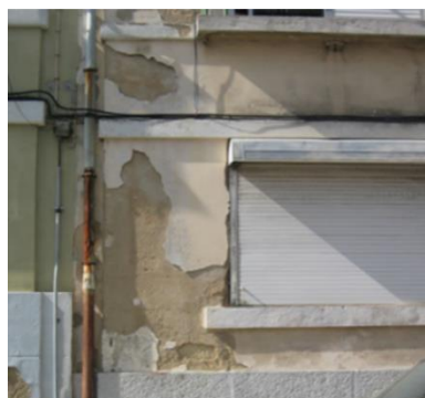
Figura 23 – Da esquerda para a direita, exemplos de destacamento, deformação e lacunas
