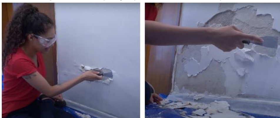
Figura 47 – Recuperação para descascamento de pintura
