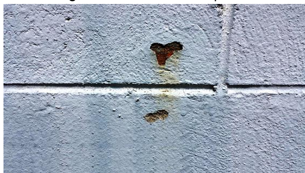
Figura 26 – Vesículas em parede
