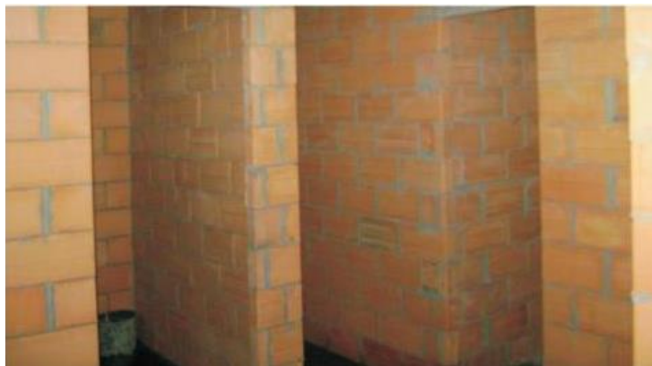
Figura 1– Alvenaria de vedação em blocos cerâmicos
