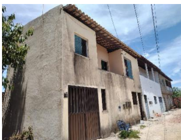
Figura 57 – Manchas de umidade encontradas na inspeção visual
