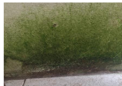
Figura 57 – Manchas de umidade encontradas na inspeção visual
