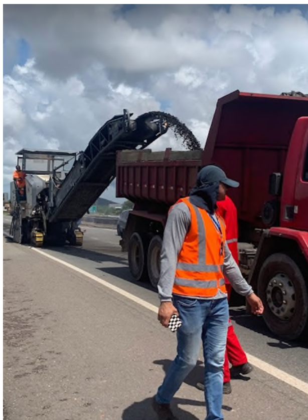
Foto 09– Caçamba recolhendo resíduo de pavimento asfáltico
