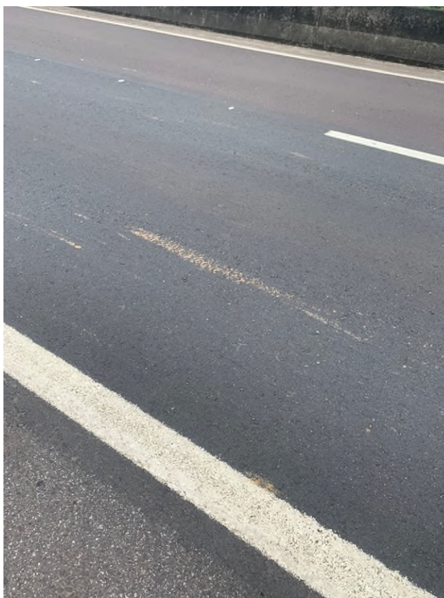
Foto 16 – Trecho KM 81,5 com recomposição executada em meia pista
