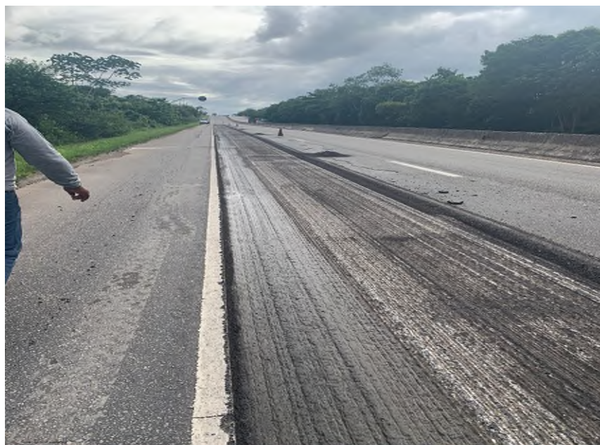
Foto 04 – Execução de fresagem no pavimento asfáltico
