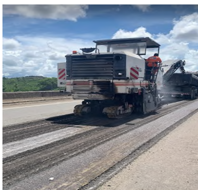
Foto 08 – Máquina fresadora executando serviço
