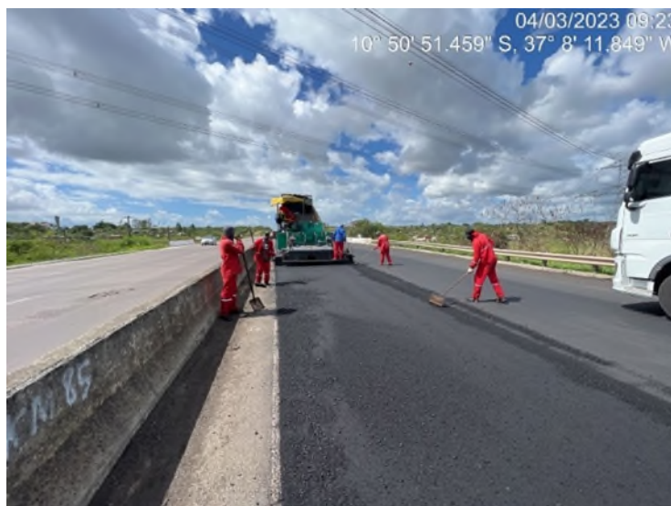
Foto 06– Execução de recomposição asfáltica com máquina pavimentadora
