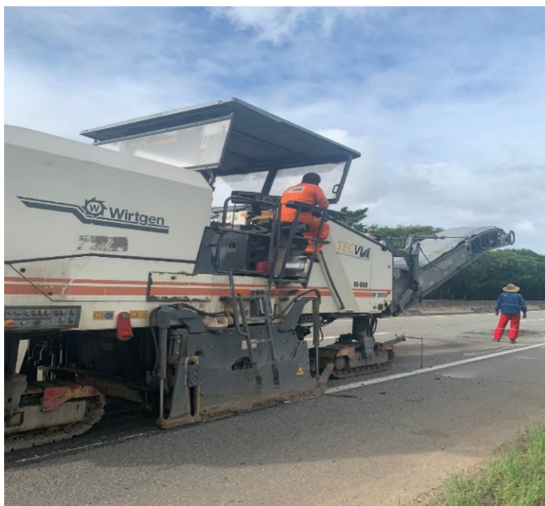
Foto 05 – Máquina fresadora de asfalto
