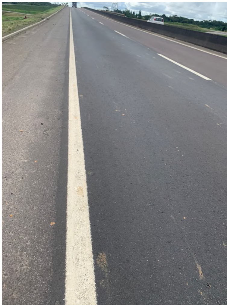
Foto 17 – Trecho KM 81,5 com recomposição executada em meia pista
