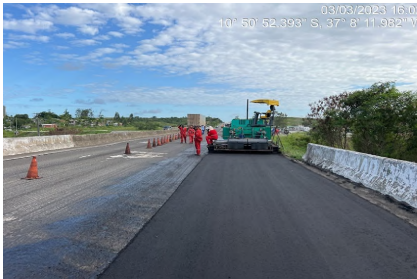
Foto 01 – Máquina de espalhamento e acabamento pavimento asfáltico.
