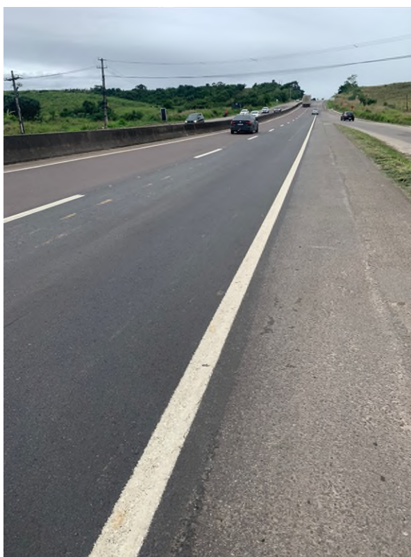
Foto 15 – Trecho KM 81,5 com recomposição executada em meia pista
