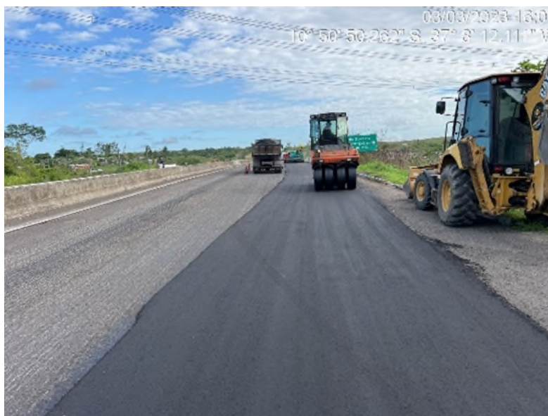
Foto 07– Detalhe da espessura do recapeamento asfáltico
