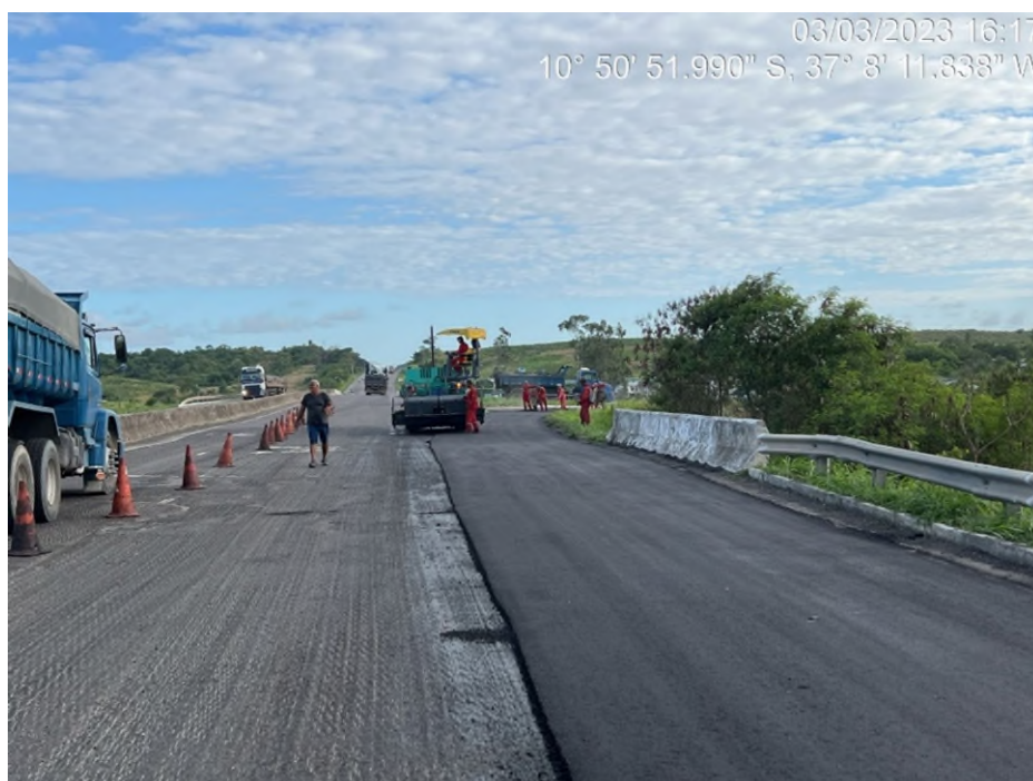
Foto 11 – Máquina pavimentadora de asfalto
