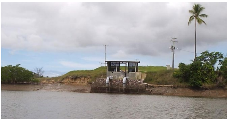
Figura 5 - Supressão do manguezal para instalação de bombas para abastecimento de tanques para carcinicultura no rio Paruí - Itaporanga d'Ajuda/SE.
