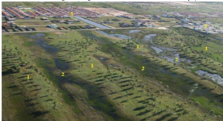
Figura 3- Vista aérea da zona de expansão Urbana de Aracaju: 1 – Sucessão de Cordões Litorâneos; 2 – Paleolagunas e lagoas freáticas; 3 – Aterramentos e Ocupação urbana.
