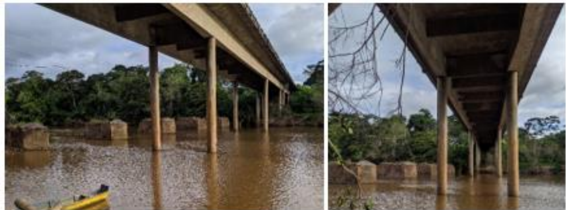
Figura 22 – Vista lateral e inferior da ponte
