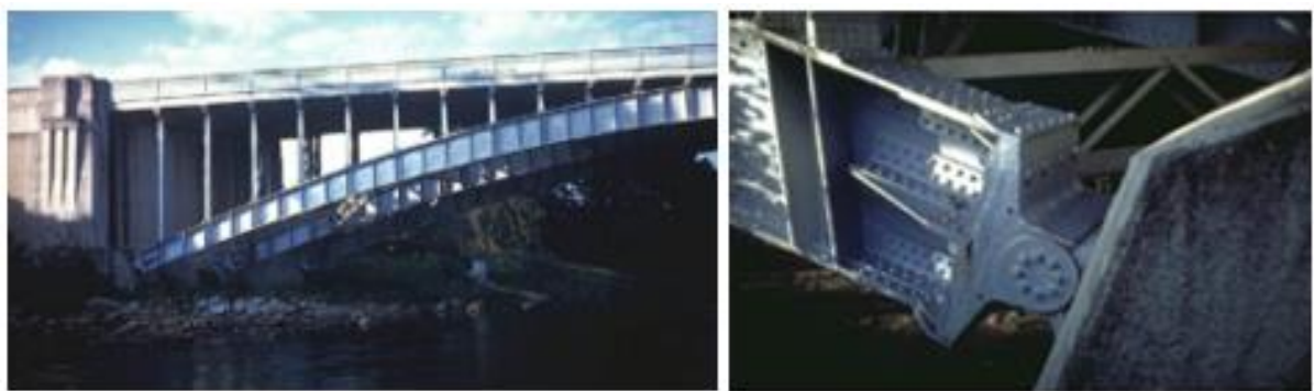
Figura 17 – Exemplo de articulação metálica - Ponte Findhorn - Escócia
