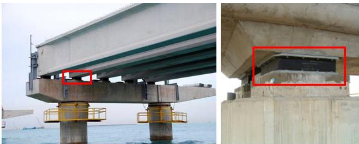
Figura 3 – Estrutura de ponte em vigas e aparelho de
