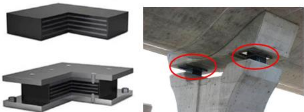
Figura 11 – Aparelho de apoio de elastômero fretado e sua utilização
