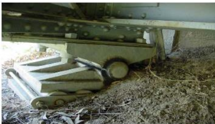
Figura 18 – Acúmulo de detritos na base de assentamento do aparelho de apoio
