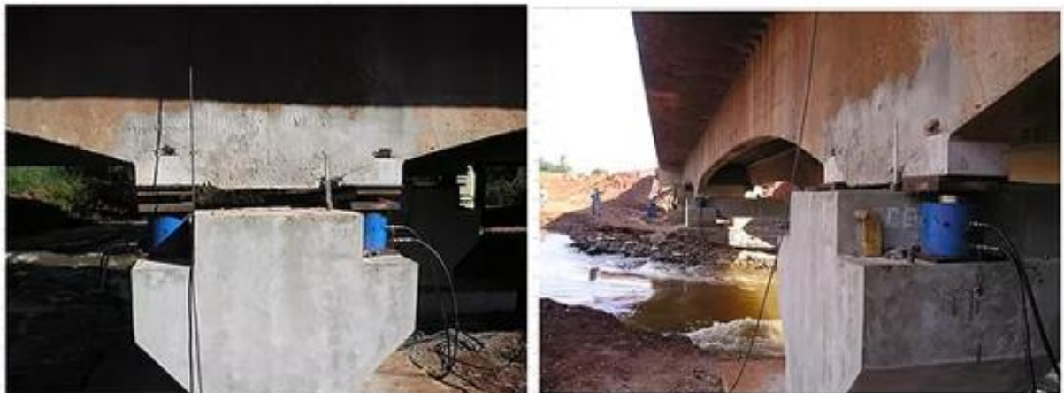
Figura 21 – Processo de macaqueamento da estrutura de ponte
