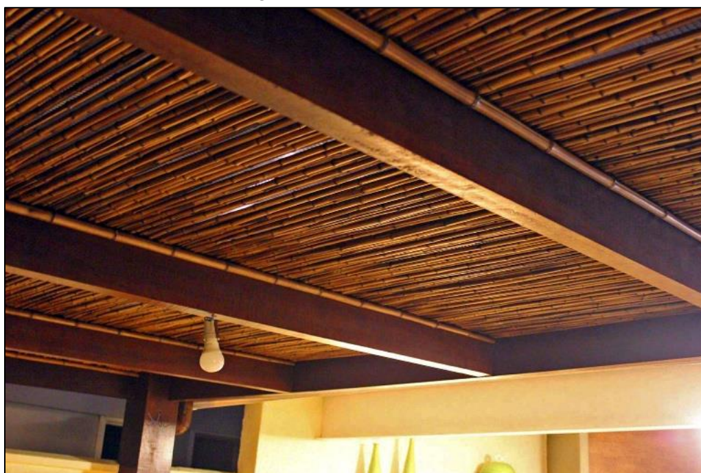
Figura 20. Forro de bambu
