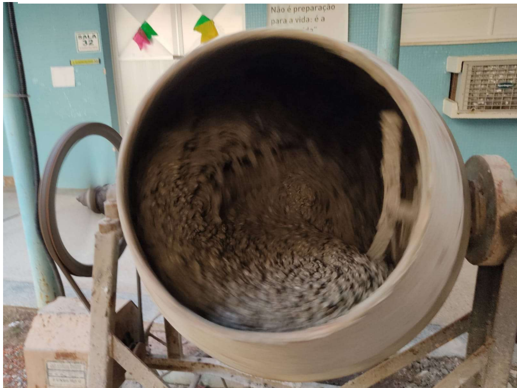
Figura 24: Concretagem no equipamento de mistura.
