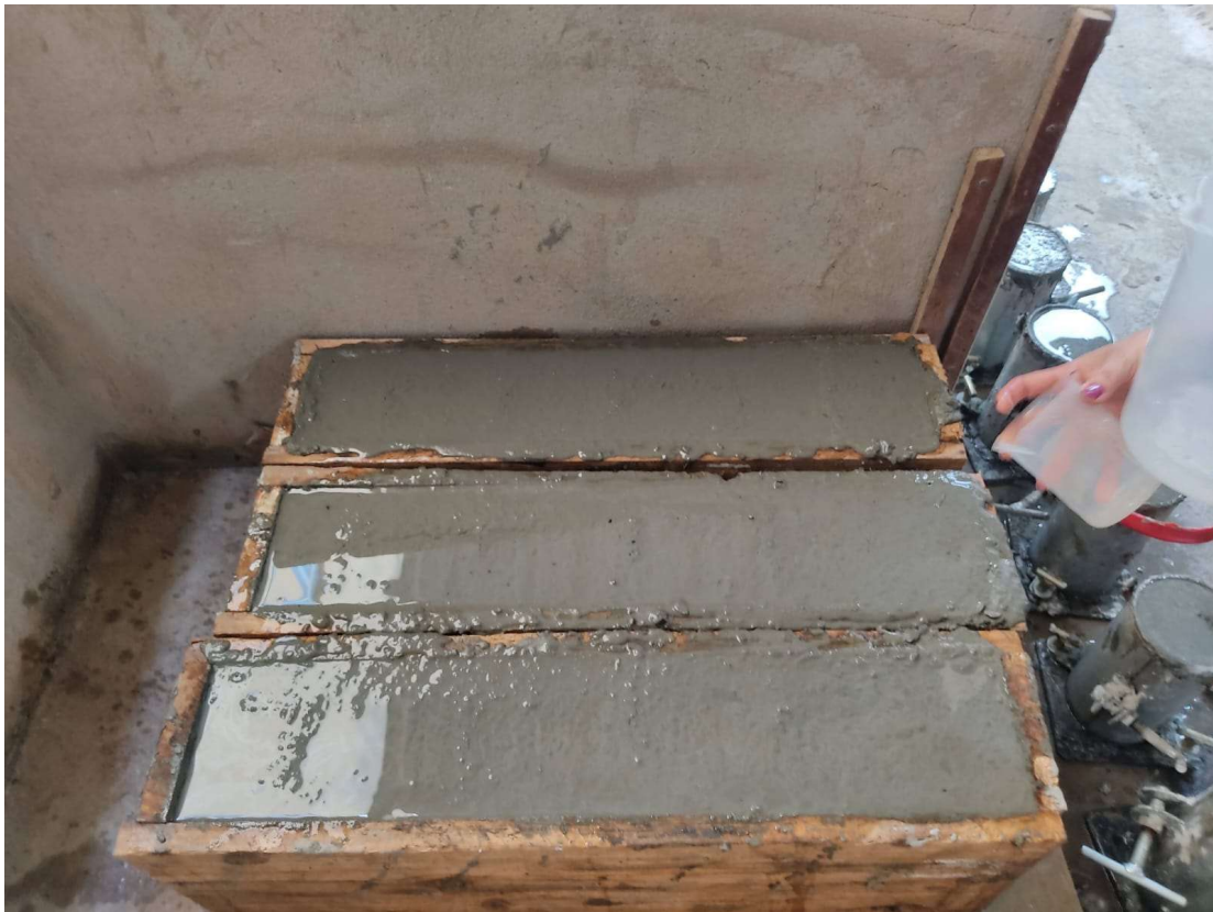
Figura 25: Cura do concreto.
