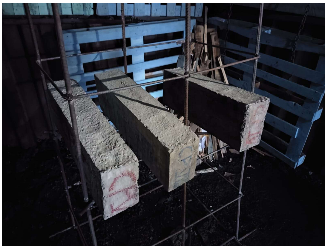
Figura 40: Disposição dos protótipos do grupo II na estrutura de aço.
