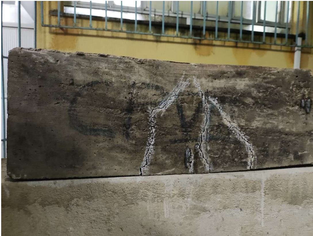
Figura 48: Protótipo de viga rompido a flexão e com fissuras de cisalhamento.
