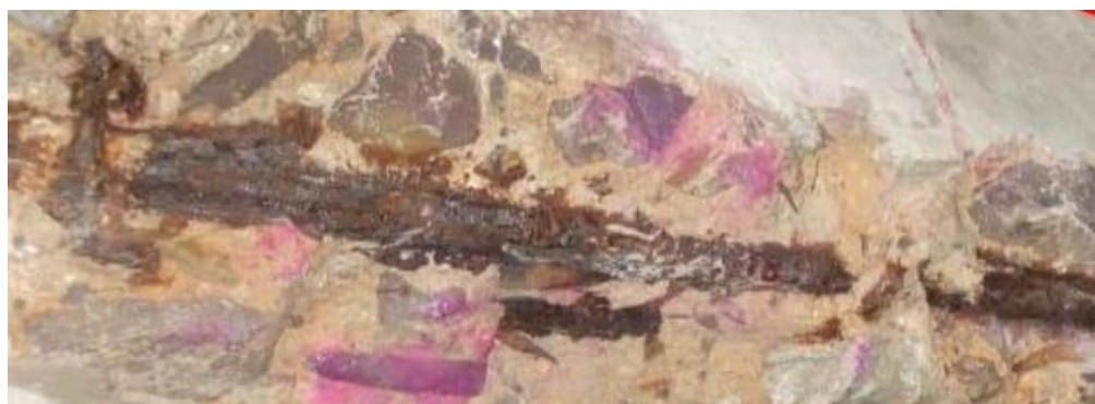
Foto 4: Viga V1 após aspersão de fenolftaleína.
