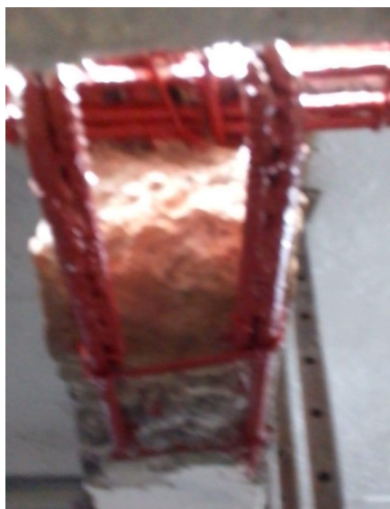
Foto 46: Aplicação de pintura anticorrosiva a base de zinco nas armaduras da viga da piscina.
