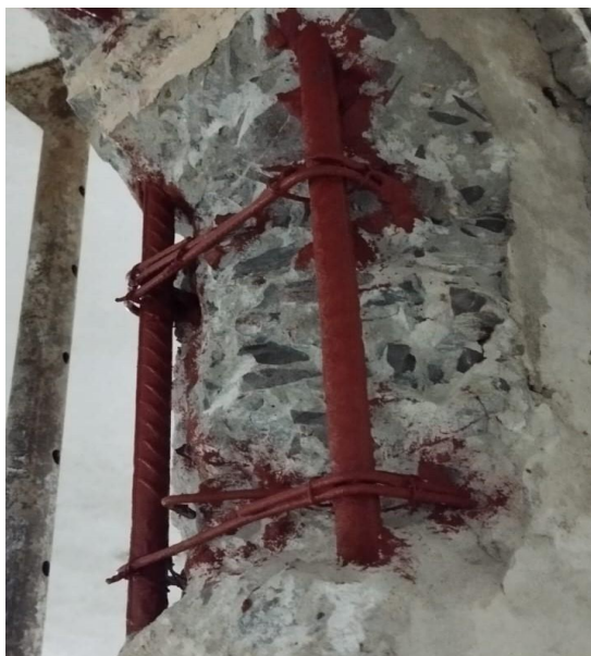
Foto 34: Aplicação de pintura anticorrosiva a base de zinco nas armaduras do pilar P3.
