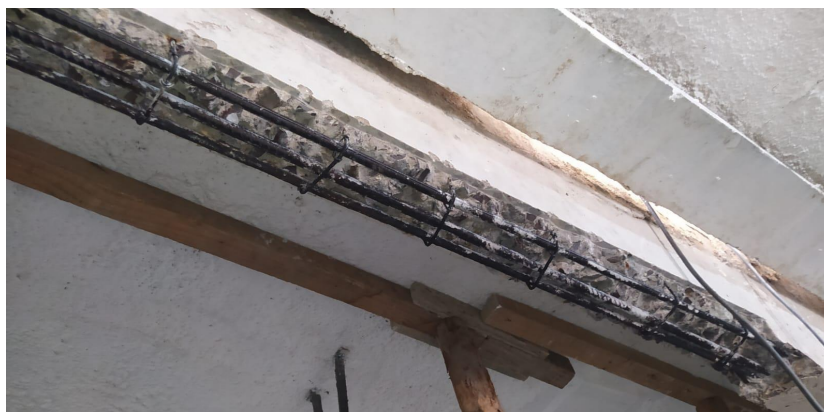
Foto 24: Armaduras após lixamento manual.
