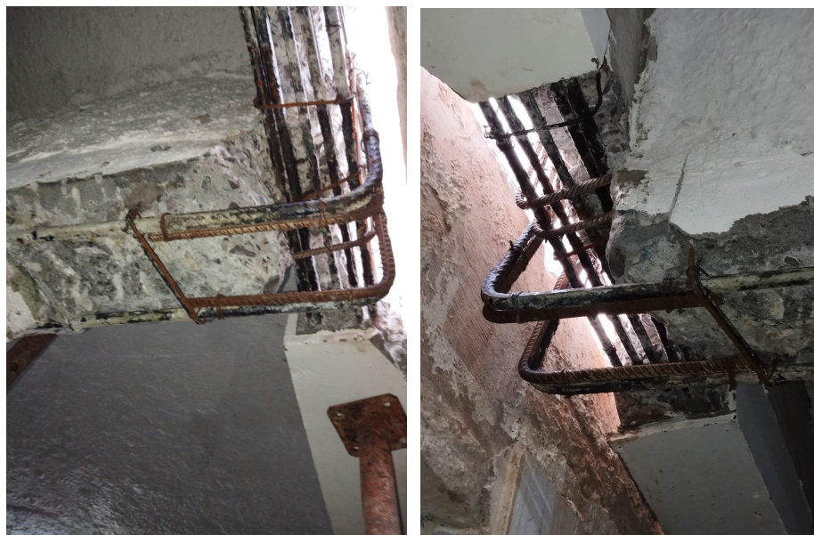
Foto 42 e 43: Suplementação das armaduras de reforço na viga da piscina.
