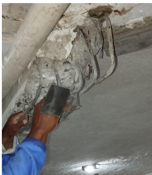
Foto 18: Lixamento manual das armaduras do console C5.
