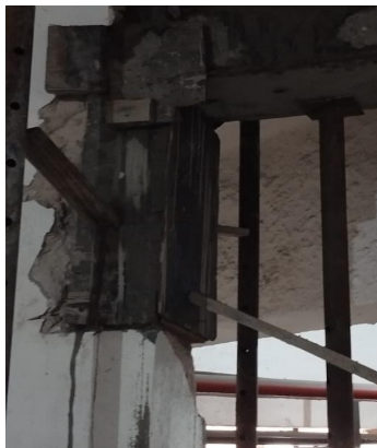
Foto 35: Grauteamento do pilar P3.
