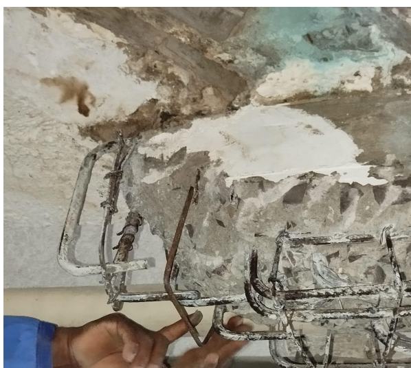
Foto 17: Suplementação de estribos do console C5.
