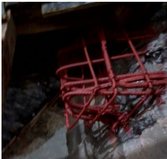
Foto 11: Aplicação de revestimento anticorrosivo à base de zinco nas armaduras do console C1.
