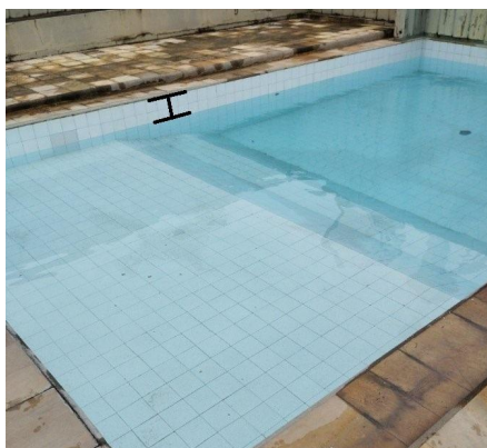
Foto 38: Rebaixo de lâmina d'água da piscina.
