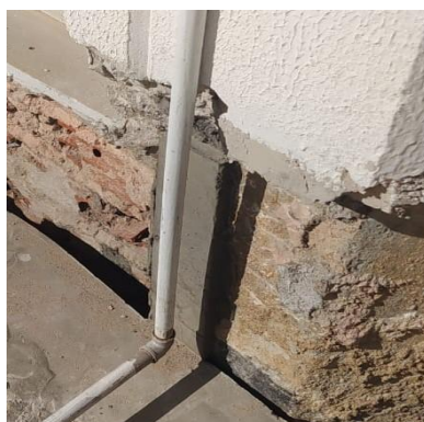
Foto 51: Janela de intervenção do pilar P15 preenchida com graute.
