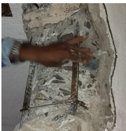
Foto 33: Lixamento das armaduras do pilar P3.
