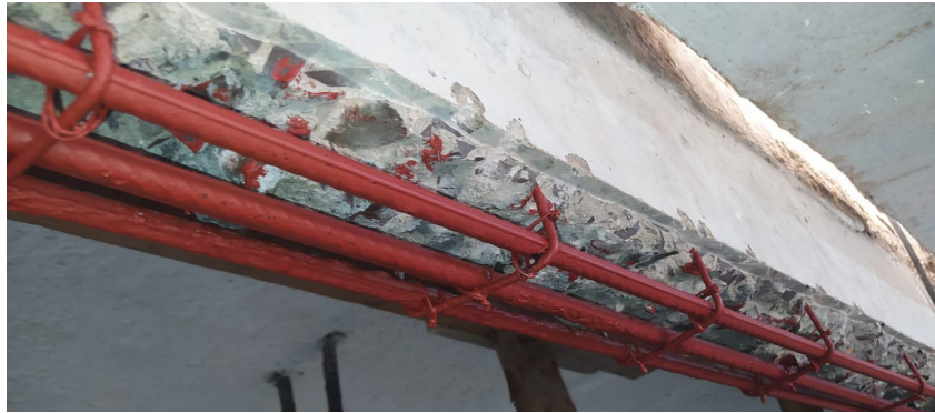
Foto 25: Pintura anticorrosiva à base zinco nas armaduras da viga V1.
