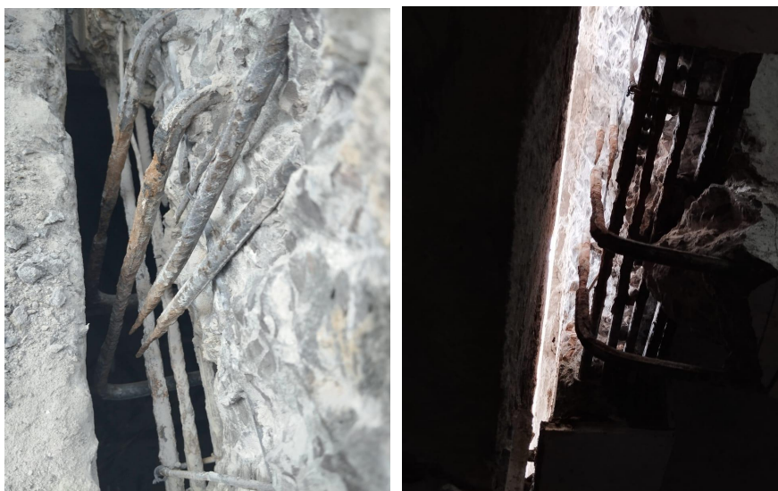
Foto 40 e 41: Abertura da janela de intervenção na cabeceira da viga da piscina.
