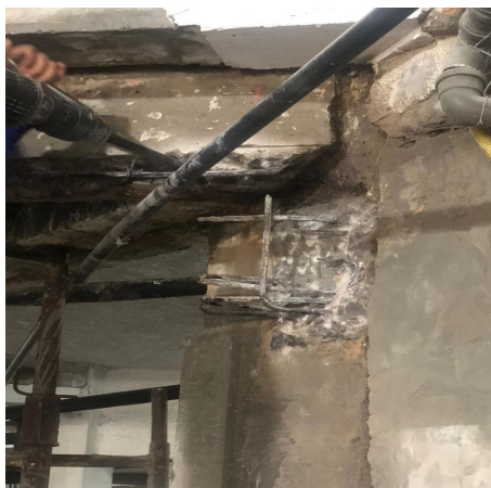
Foto 8: Escarificação com martelete do console C1.
