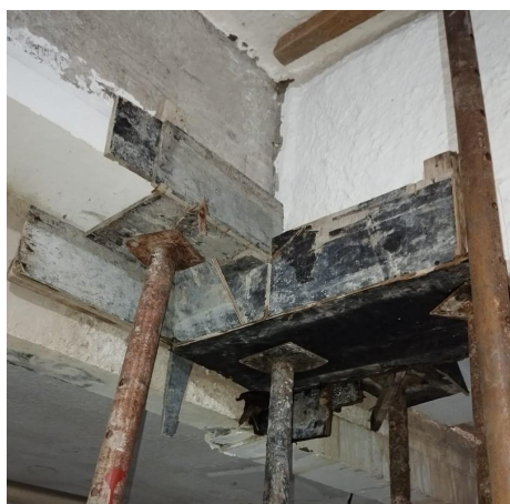
Foto 47: Grauteamento da cabeceira da viga da piscina.
