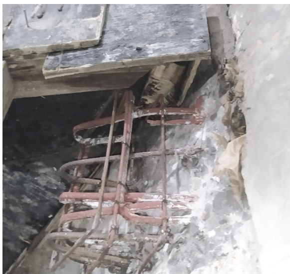
Foto 10: Suplementação das armaduras do console C1.
