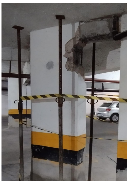
Foto 30: Escoramento pilar P3.
