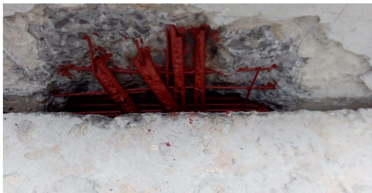
Foto 45: Aplicação de pintura anticorrosiva a base de zinco nas armaduras da viga da piscina.
