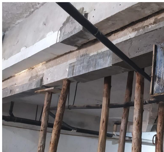
Foto 7: Escoramento da laje e vigas do playground.
