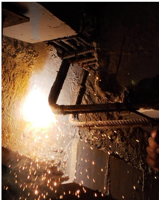
Foto 44: Soldagem em filetes da armadura de reforço na viga da piscina.
