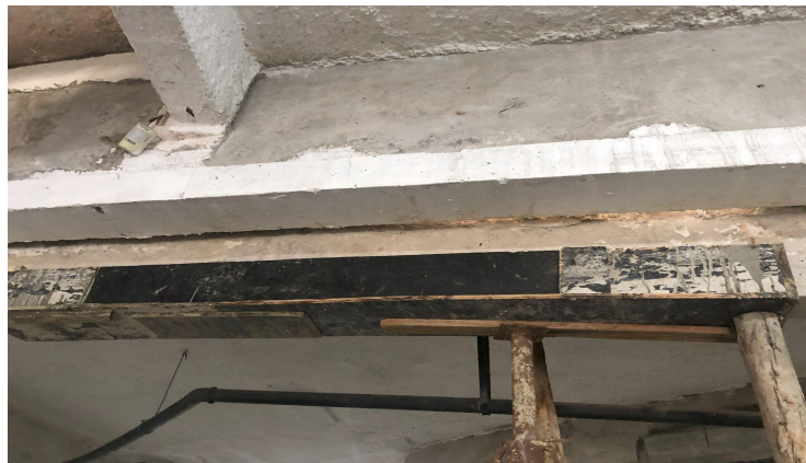
Foto 26: Grauteamento da Viga V1.
