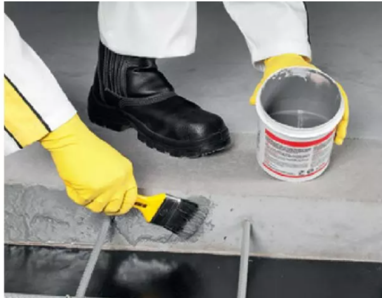
Figura 13: Aplicação de adesivo epóxi fluido na superfície do concreto antigo.
