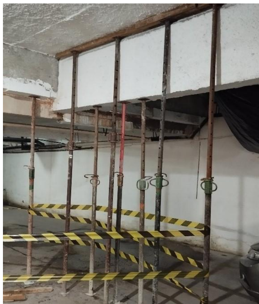
Foto 39: Escoramento da viga da piscina.
