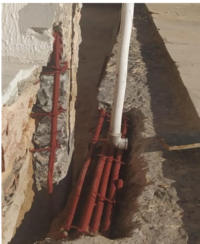
Foto 50: Aplicação de pintura anticorrosiva a base de zinco no pilar P15.
