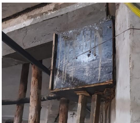
Foto 12: Grauteamento do console C1.
