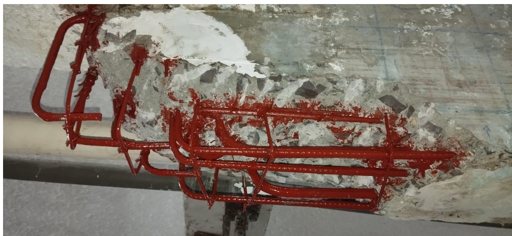
Foto 19: Aplicação de pintura anticorrosiva à base de zinco no console C5.
