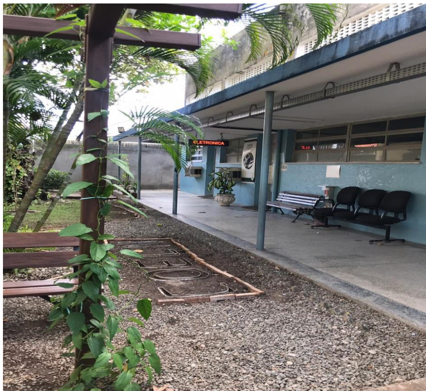
Figura 2 - Pavilhão de Eletrônica, Campus Aracaju
