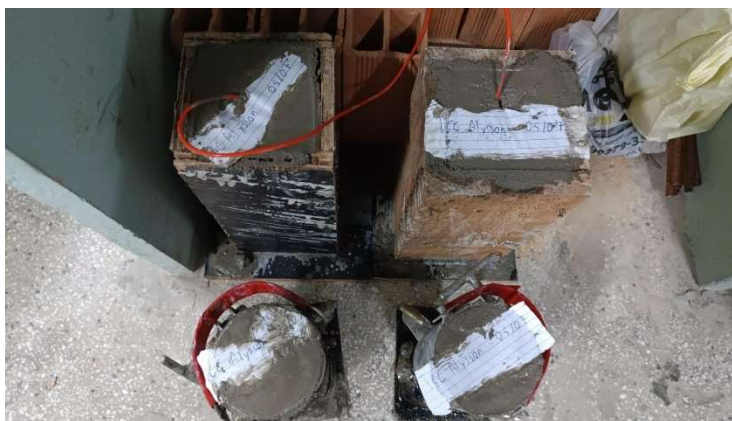
Figura 9 - Concretagem dos corpos de prova
