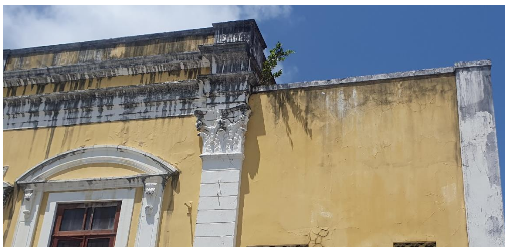
Foto 10 - Presença de vegetação na cobertura
