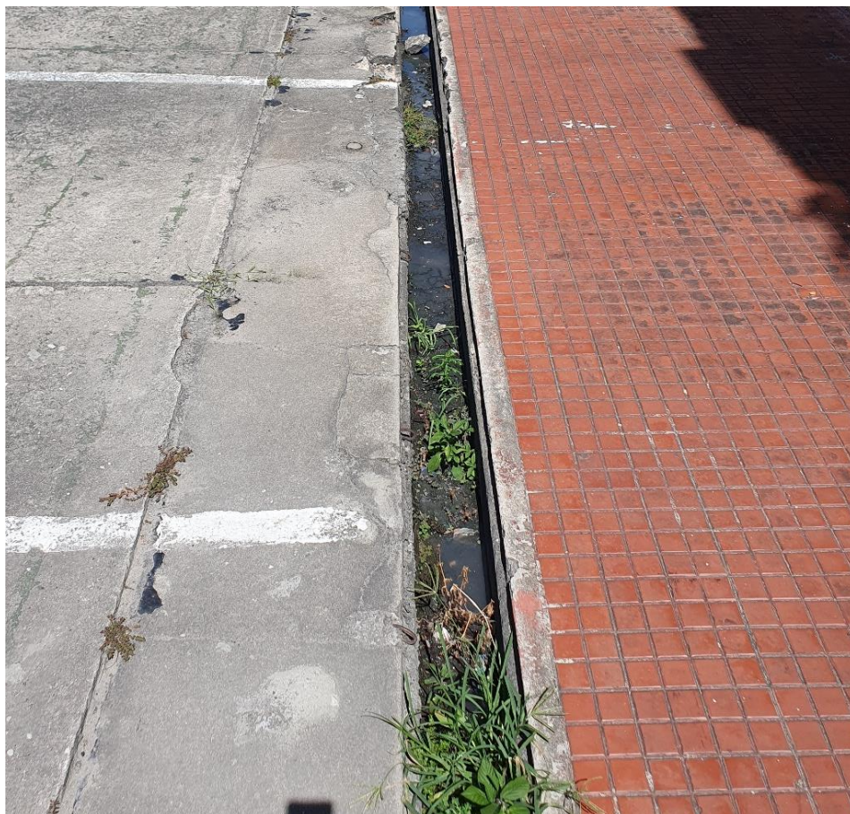
Foto 3 - Drenagem obstruída
