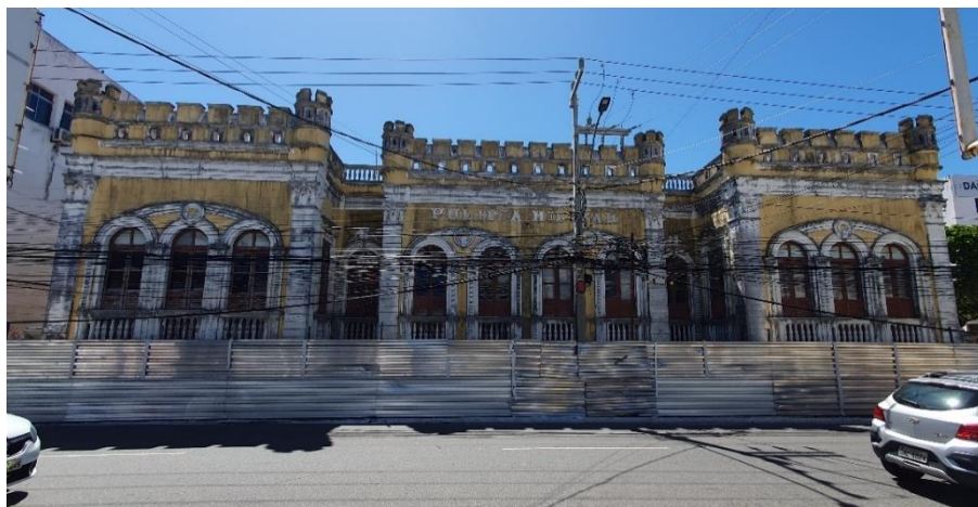
Foto 2 - Vista frontal do prédio
