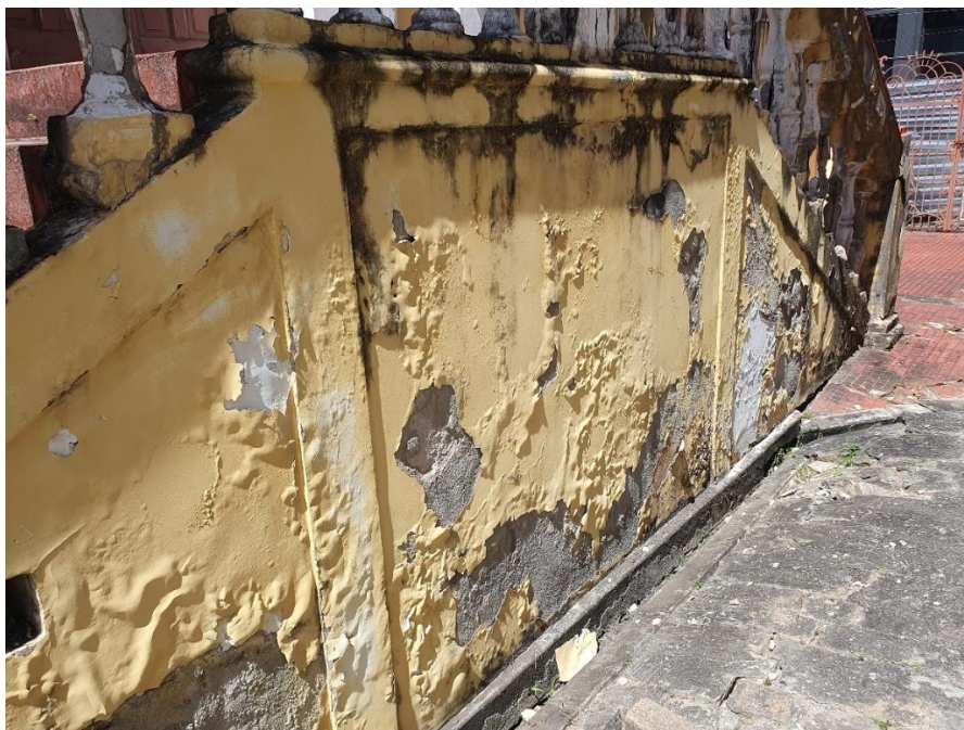
Foto 6 - Estado aparente do reboco
