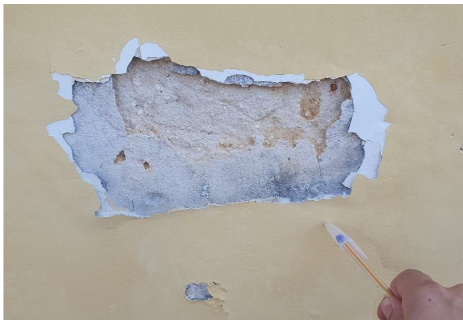
Foto 15 - Reboco comprometido
