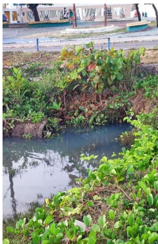
Figura 2. Despejo clandestino de esgoto doméstico Autor(a): Roberta Muniz, 2023.
