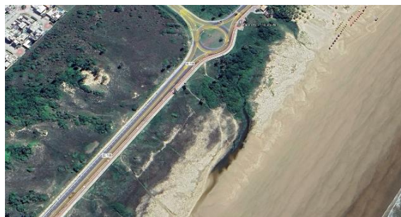
Figura 14 – Esgoto do canal de drenagem do Bairro Aruana escoando em direção à praia.
