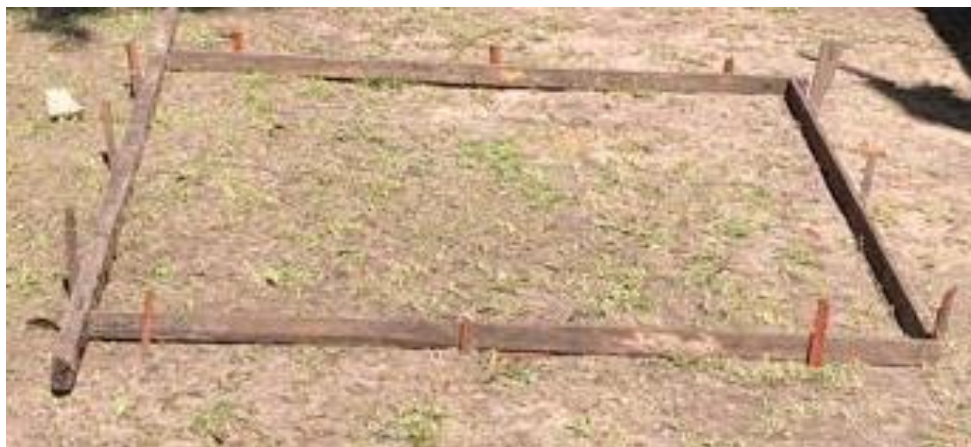
Figura 8 – Fôrma para execução do contrapiso
