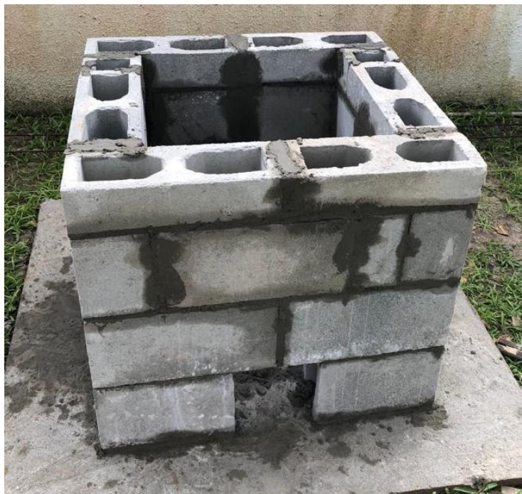
Figura 11 – Execução da alvenaria de blocos de concreto
