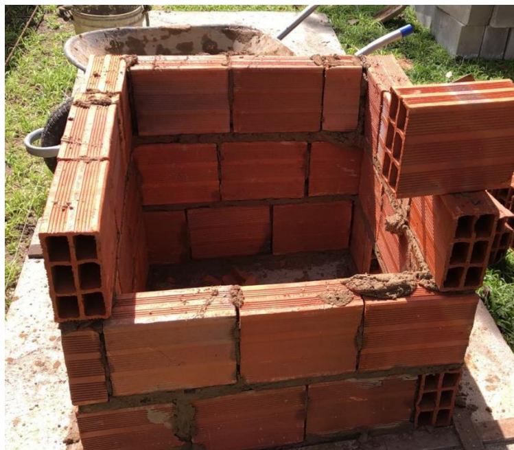
Figura 10 – Execução da alvenaria de blocos cerâmicos
