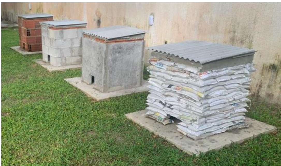
Figura 13 – Conclusão dos protótipos
