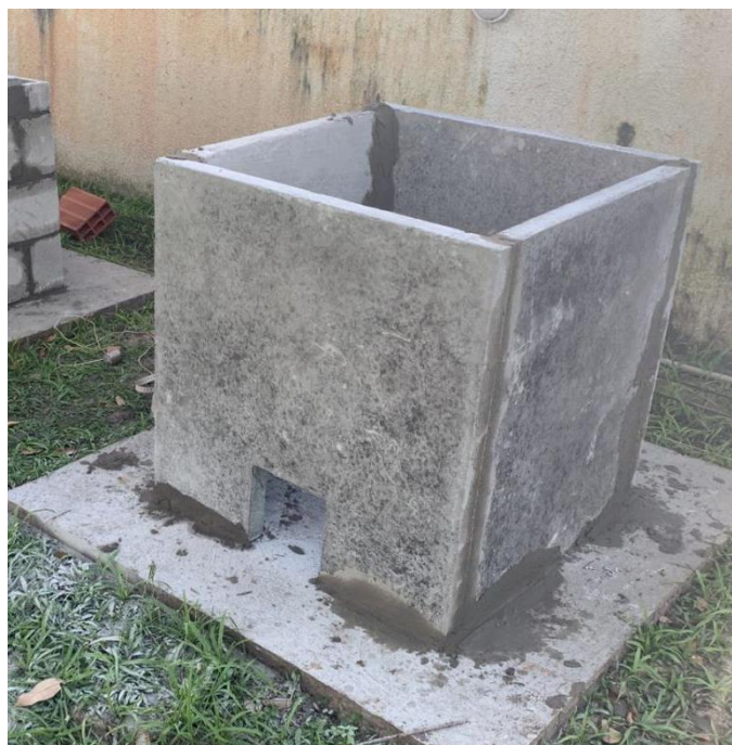
Figura 12 – Montagem das paredes pré-moldadas de concreto armado
