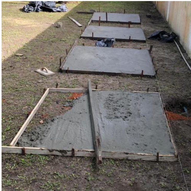
Figura 9 – Concretagem dos lastros
