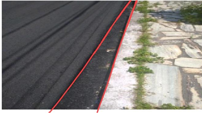
Figura 04: Sarjeta Moldada com Massa Asfáltica
