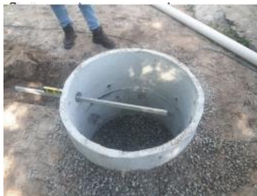
Figura 16: Colocação da Brita
