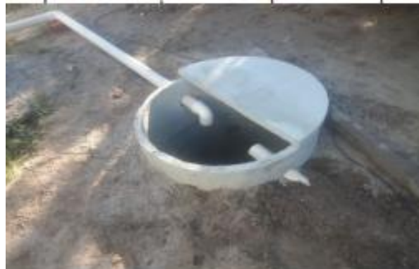
Figura 19: Tampa de Concreto
