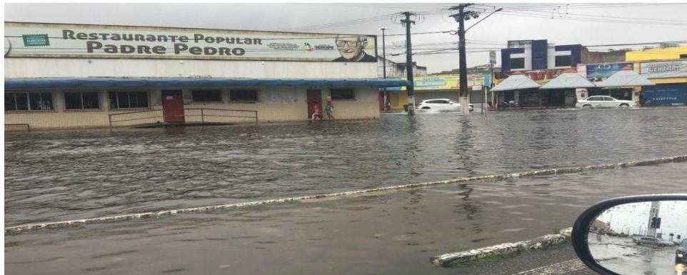
Figura 36: Alagamento na Avenida Coelho e Campos
