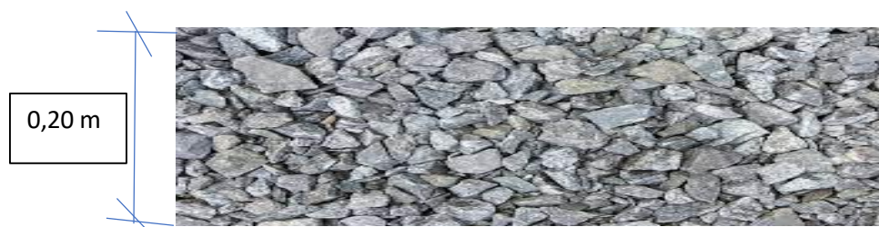
Figura 50: Espessura da camada de brita da rua Coelho e Campos
