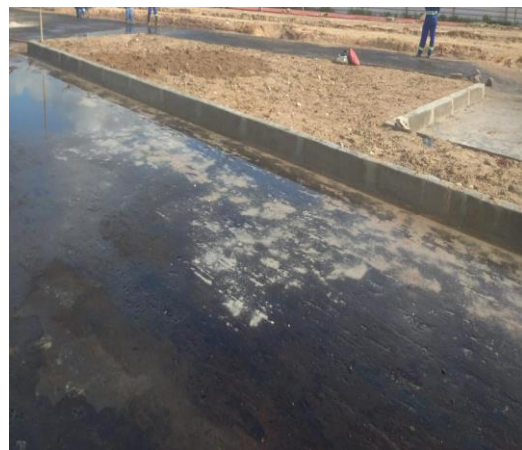
Figura 03: Meio fio Canteiro
