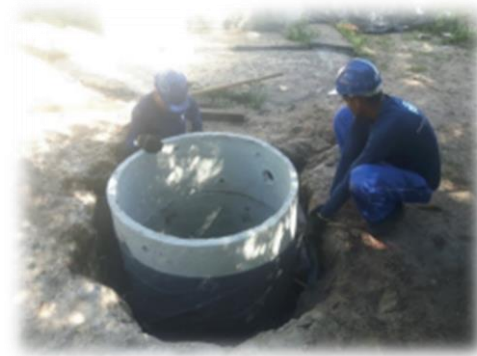
Figura 15: Colocação da Manta
