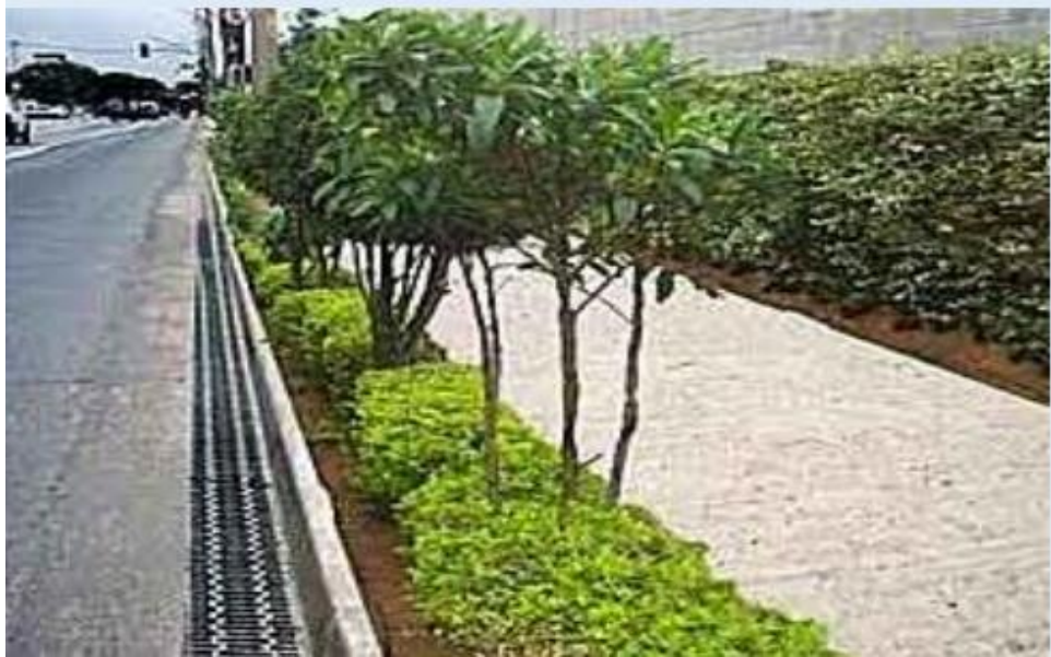
Figura 34: Vala de Infiltração
