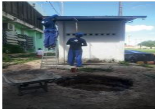
Figura 13: Calha da Cobertura
