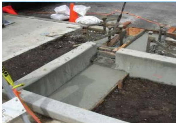
Figura 30: Concretagem das áreas de entrada e saída
