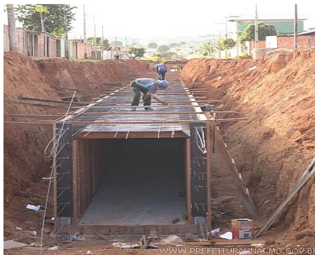
Figura 09: Galerias Pré- moldadas
