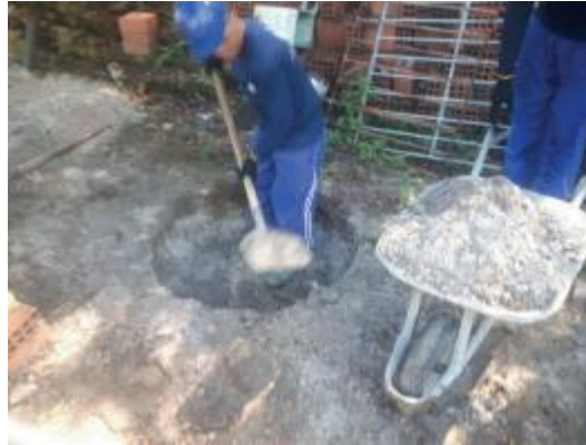
Figura 12: Escavação do poço
