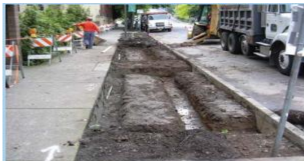
Figura 28: Retirada da cobertura inicial e escavação
