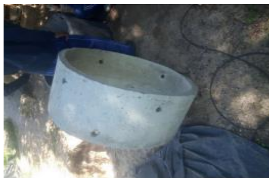
Figura 14: Instalação dos Anéis
