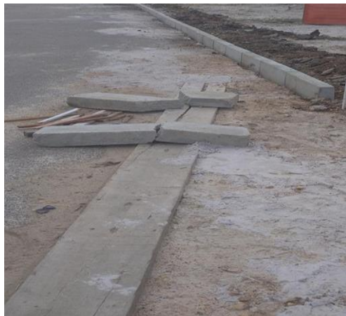
Figura 02: Instalação de meio fio
