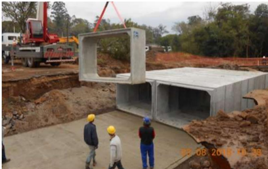
Figura 8 - Execução de galeria de macrodrenagem
