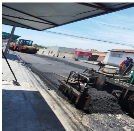
Figura 21 - Execução de Pavimentação Asfáltica
