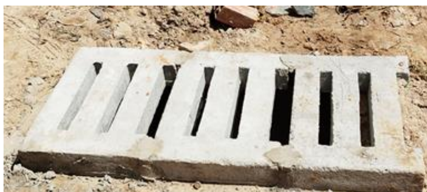
Figura 5 - Boca de Lobo
