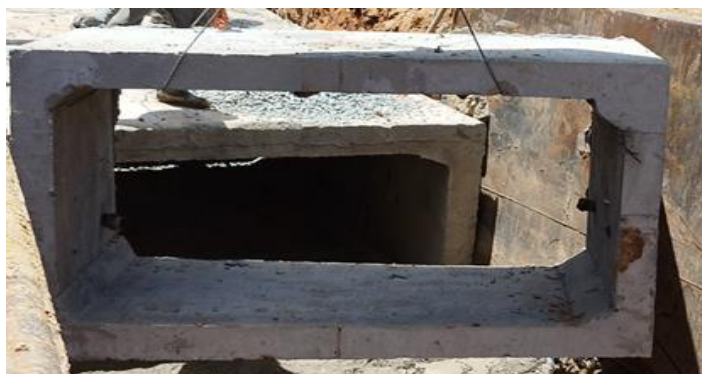
Figura 6 - Galeria de Concreto Armado
