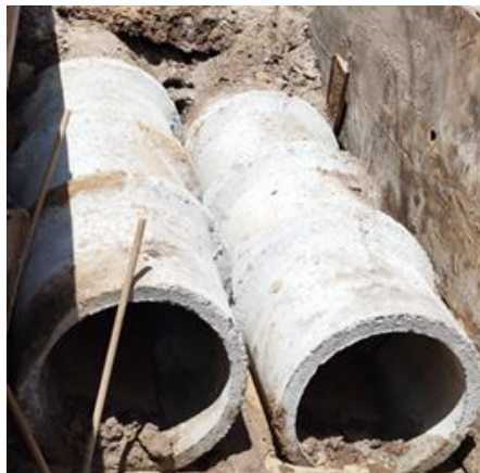
Figura 18 - Escoramento de Vala
