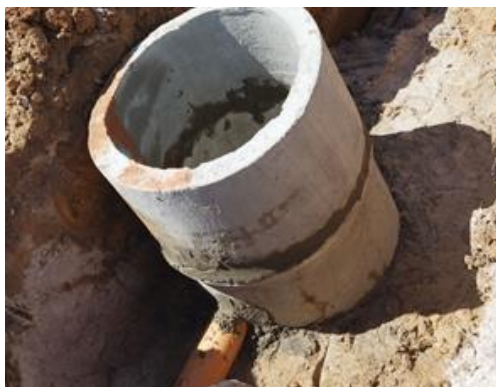
Figura 11 - Assentamento de PV com a junta rígida
