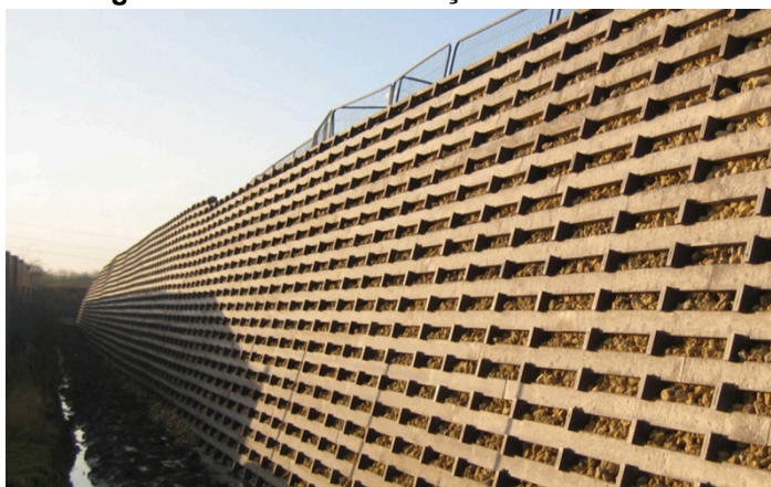
Figura 5 - Muro de contenção em “crib wall”
