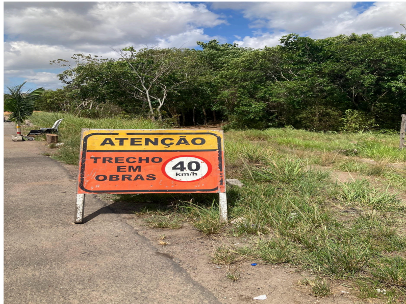
Fotografia 13 - Placas de sinalização da obra
