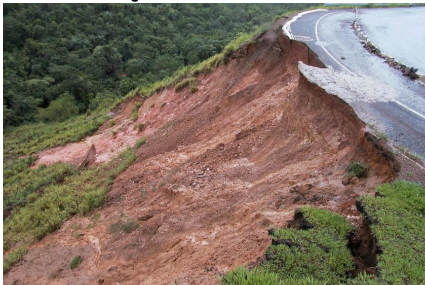
Figura 1 - Talude em rodovia
