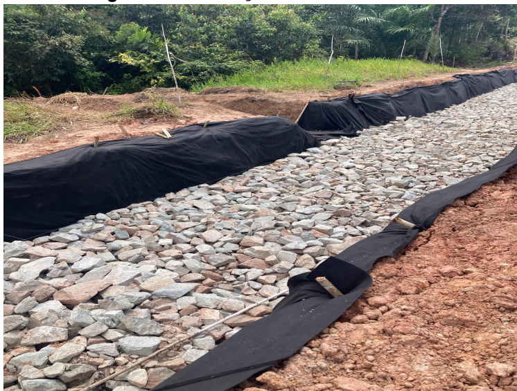
Fotografia 3 - Execução do colchão drenante
