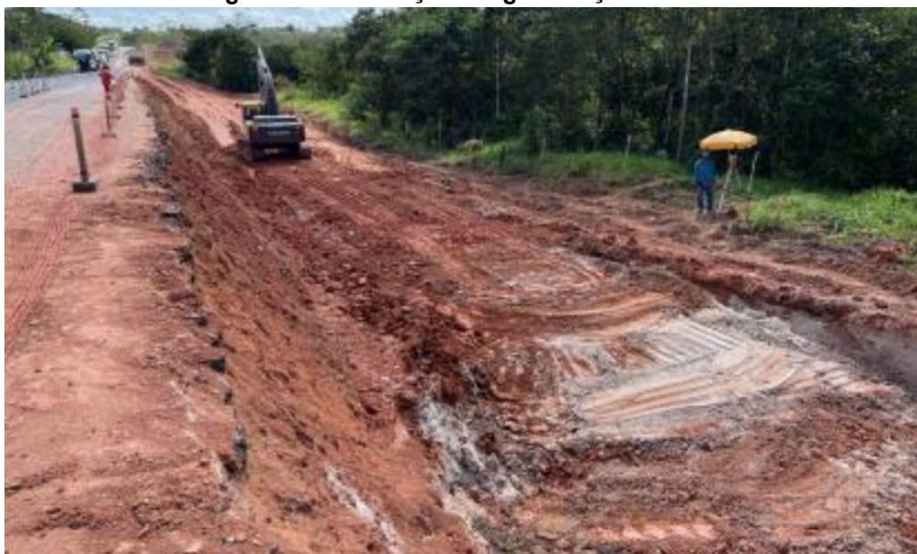
Fotografia 2 - Escavação e regularização do terreno
