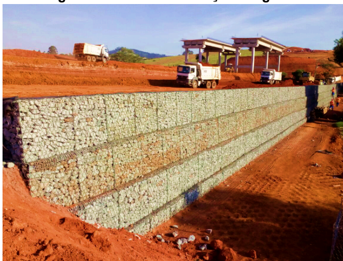
Figura 6 - Muro de contenção em gabião
