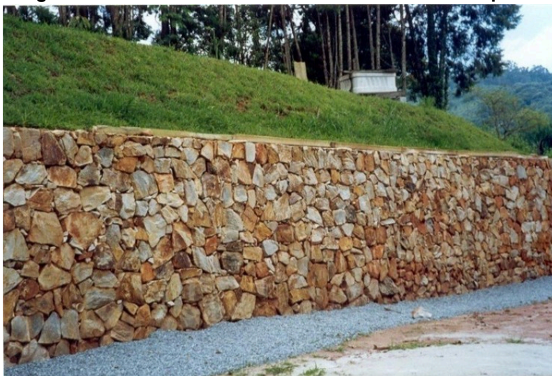
Figura 2 - Muro de arrimo executado em alvenaria de pedra
