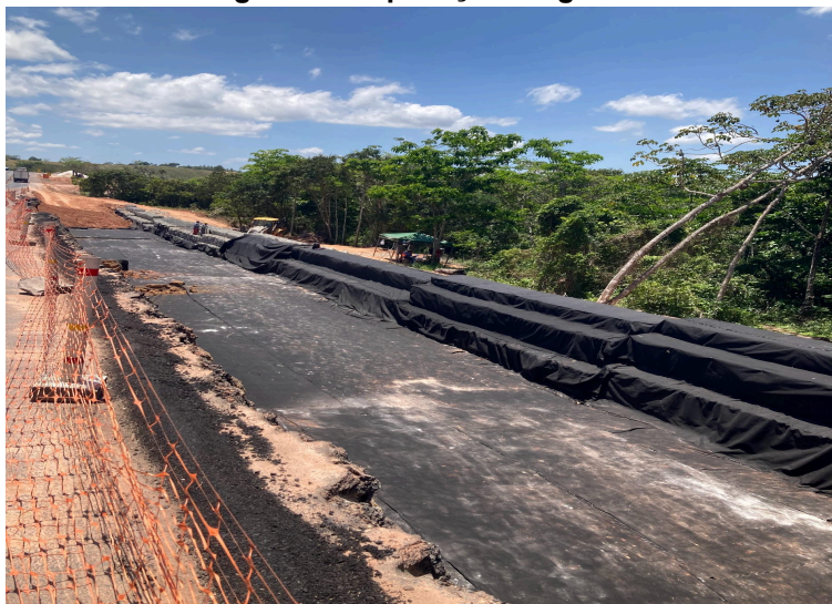
Fotografia 7 - Aplicação do geotêxtil
