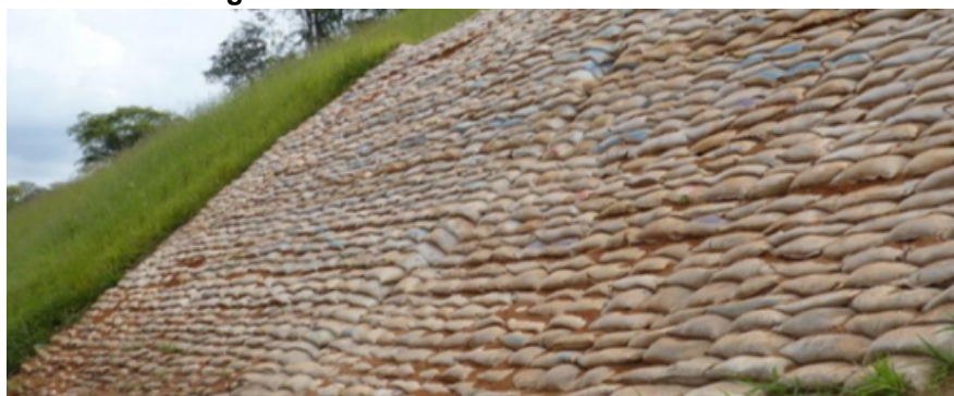
Figura 4 - Muro de sacos de solo-cimento
