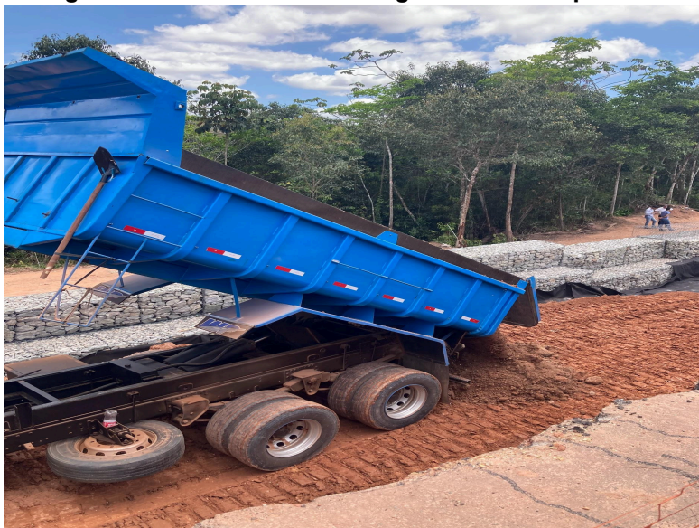
Fotografia 8 - Caminhão descarregando material para aterro
