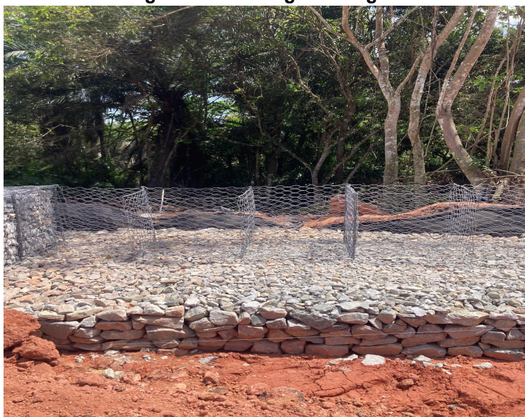
Fotografia 5 - Montagem das gaiolas
