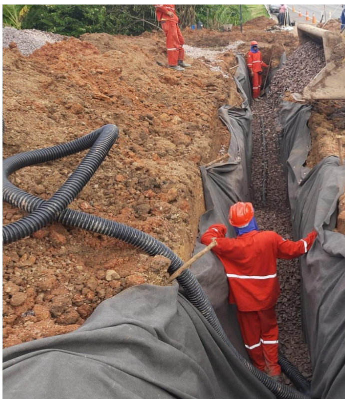
Fotografia 1 - Construção de dreno no acostamento oposto ao talude
