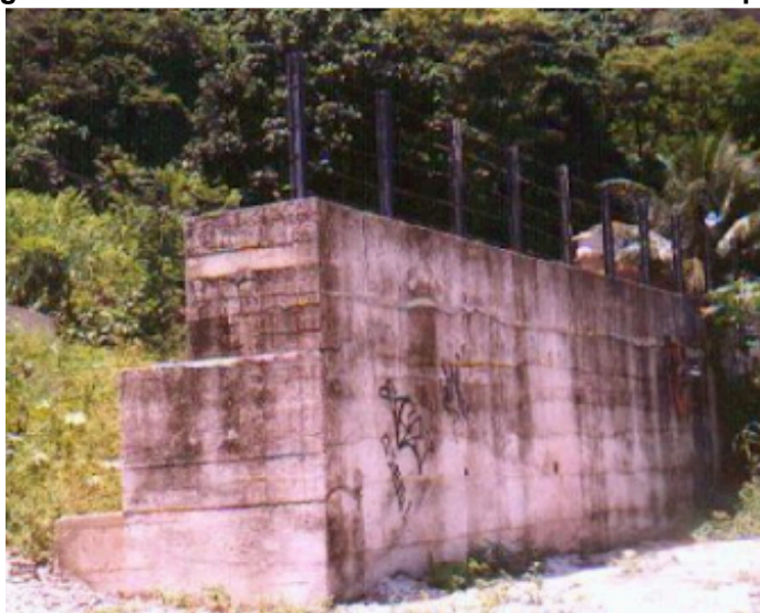
Figura 3 - Muro de arrimo executado em concreto ciclópico
