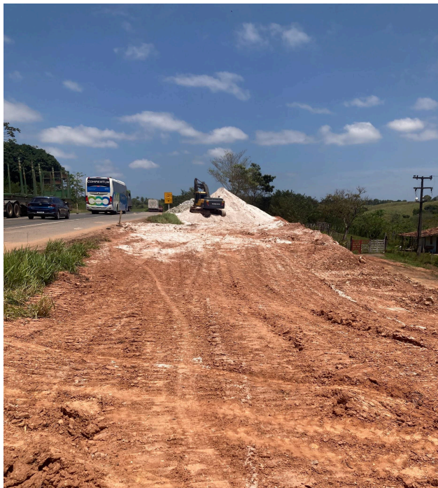
Fotografia 11 - Canteiro na fase inicial da obra e sem banheiro químico
