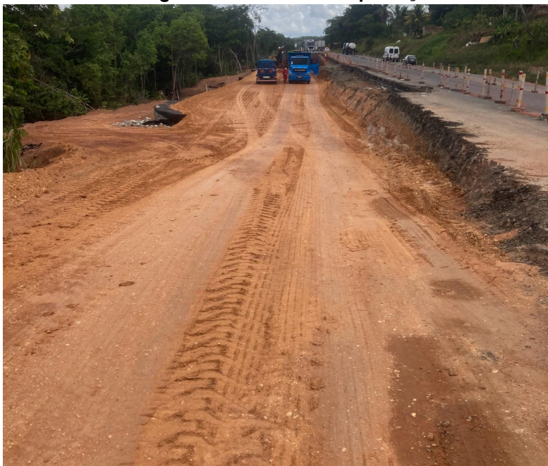
Fotografia 9 - Aterro e compactação
