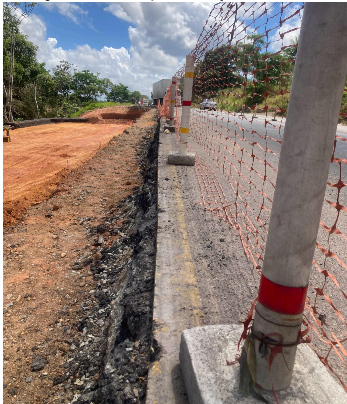
Fotografia 14 - Tela tapume laranja cercando a obra
