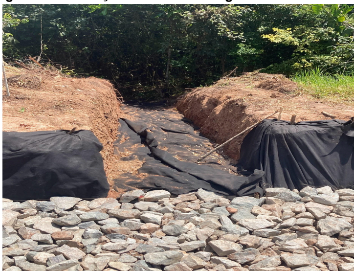
Fotografia 4 - Execução de dreno ao longo do muro de contenção
