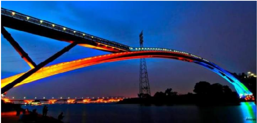
Figura 3: Passarela daz paz construída com CPR.
