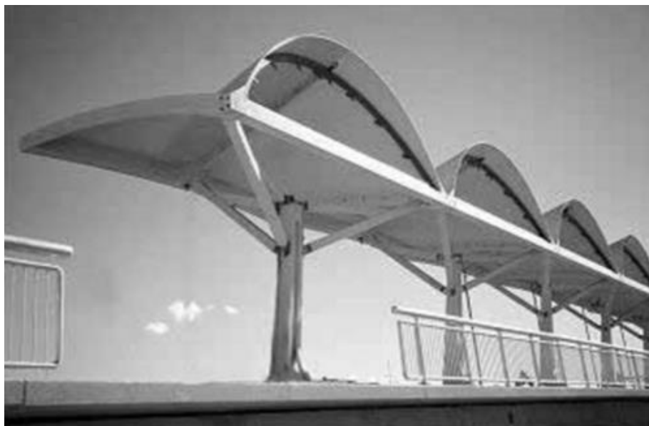
Figura 5: Ponto de ônibus com cobertura de CPR em Shawnessy no Canadá.
