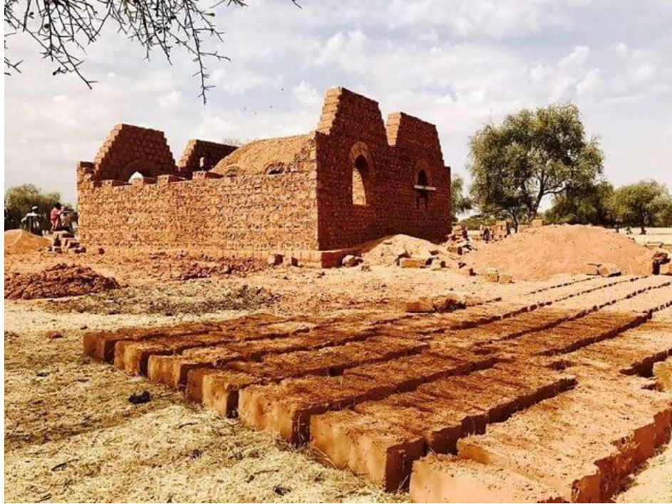
Figura 2: Construção de casa de adobe.
