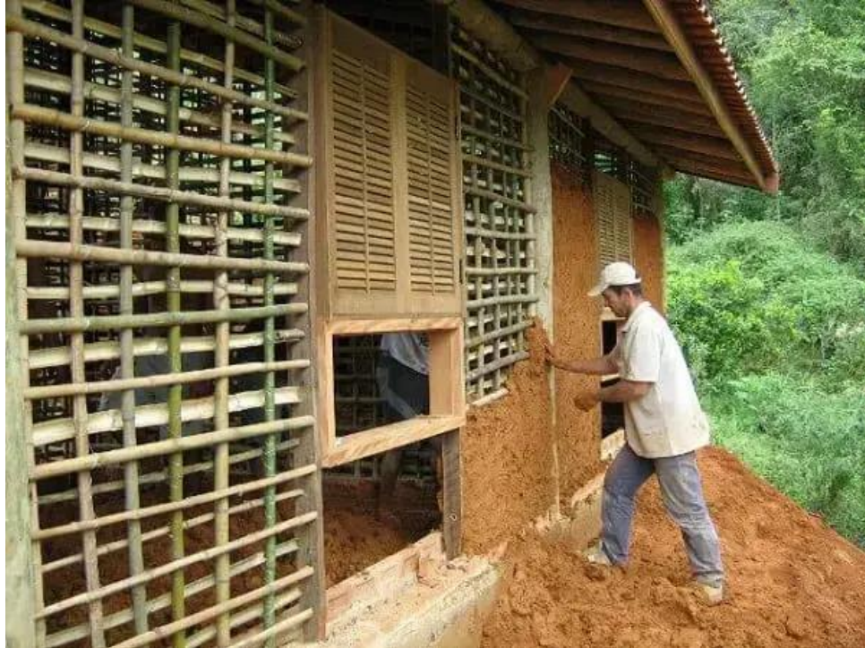
Figura 3: Construção de taipa de mão.
