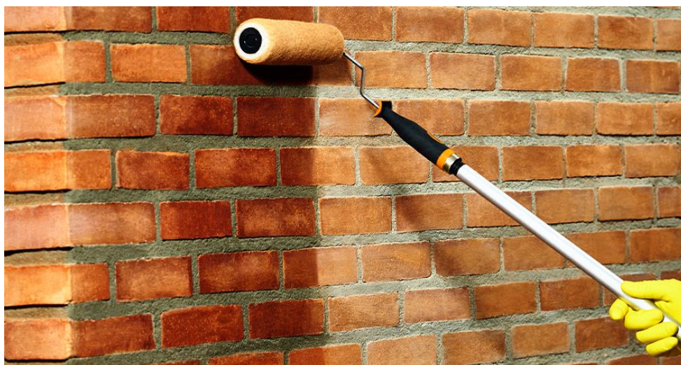
Figura 6: Aplicação de impermeabilizante.
