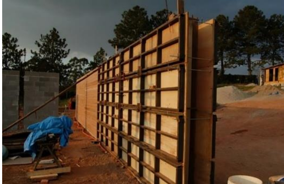
Figura 5: Construção de paredes monolíticas.
