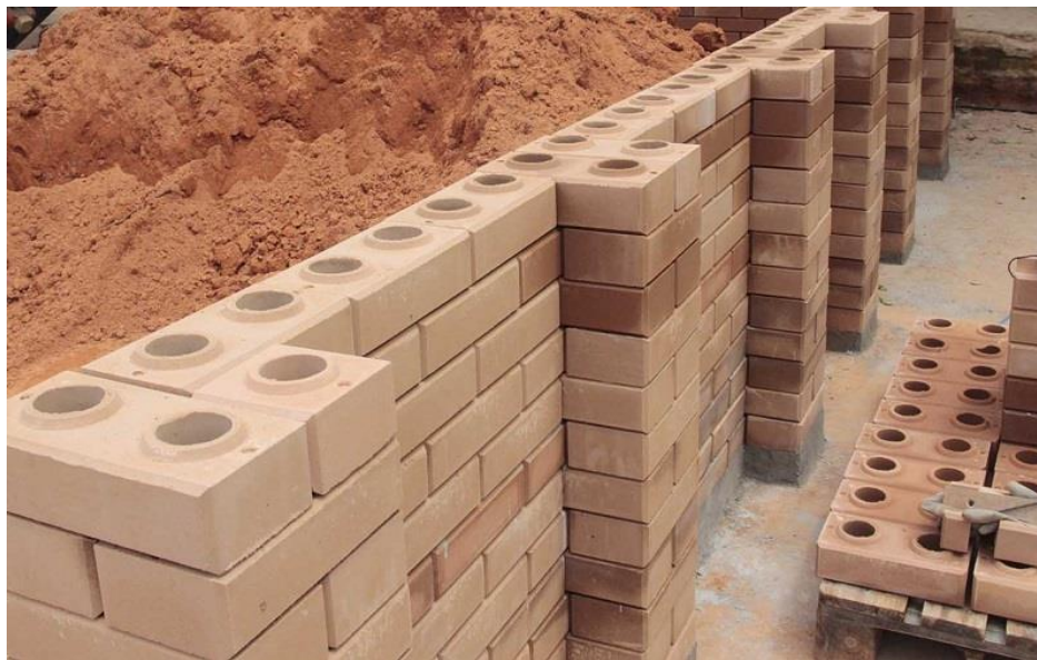
Figura 4: Construção de tijolo ecológico.
