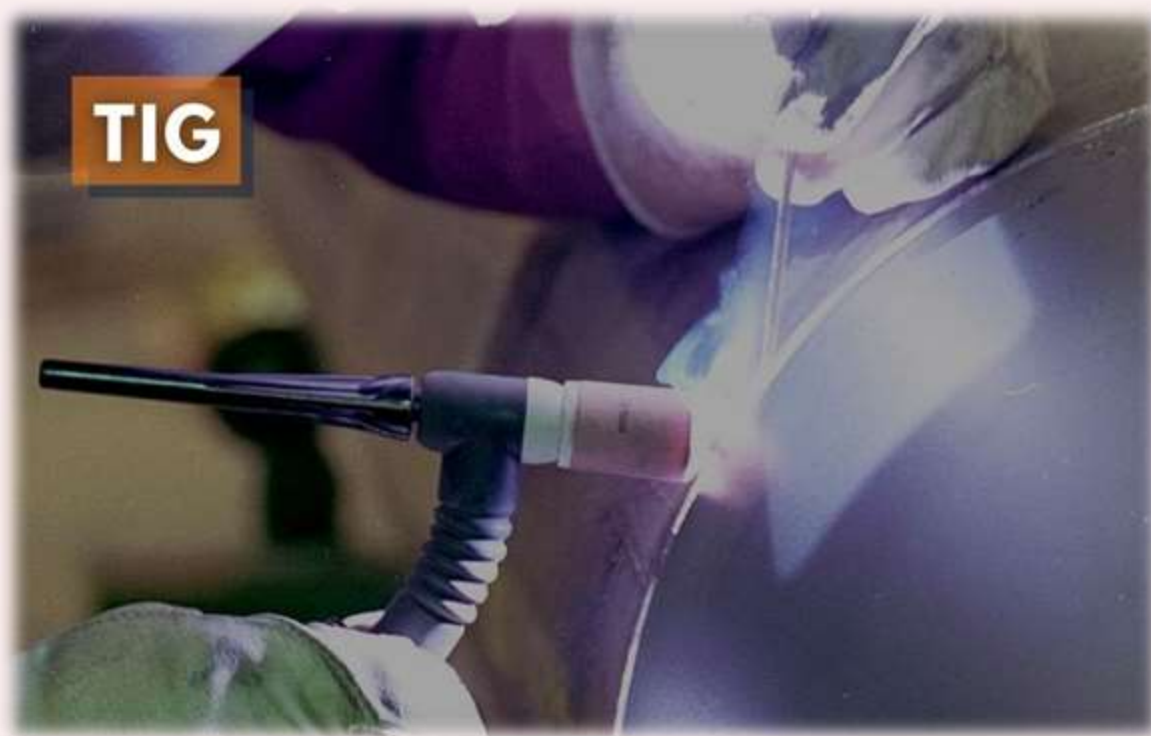
Fig. 25 – Execução da técnica de solda TIG
