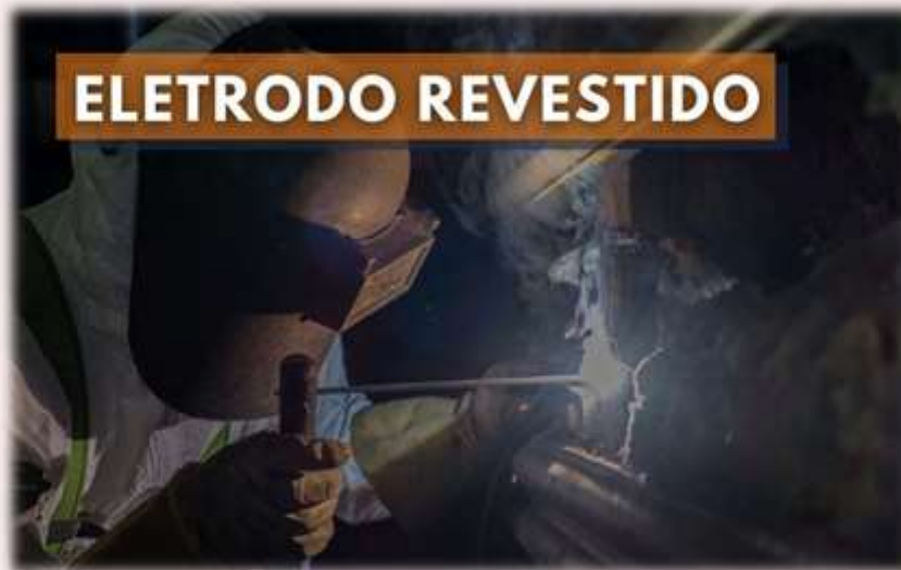
Fig.21 – Soldagem eletrodo revestido
