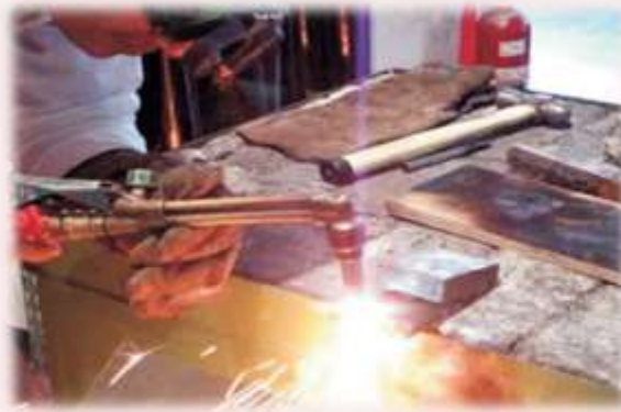
Figura 37 – Execução de um corte térmico com maçarico
