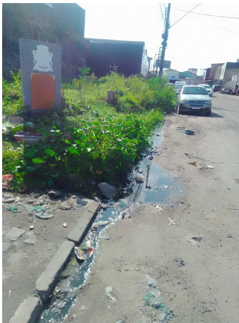
Figura 18 - Esgoto a céu aberto e lixo espalhado na via
