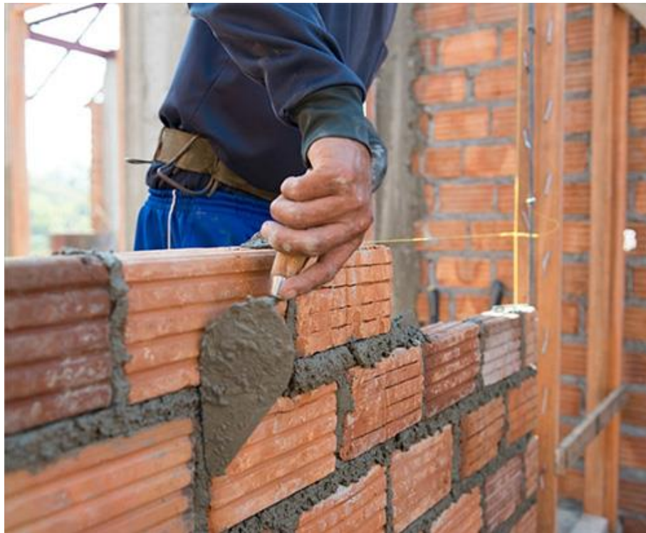
Figura 6 - Construção de paredes com blocos cerâmicos
