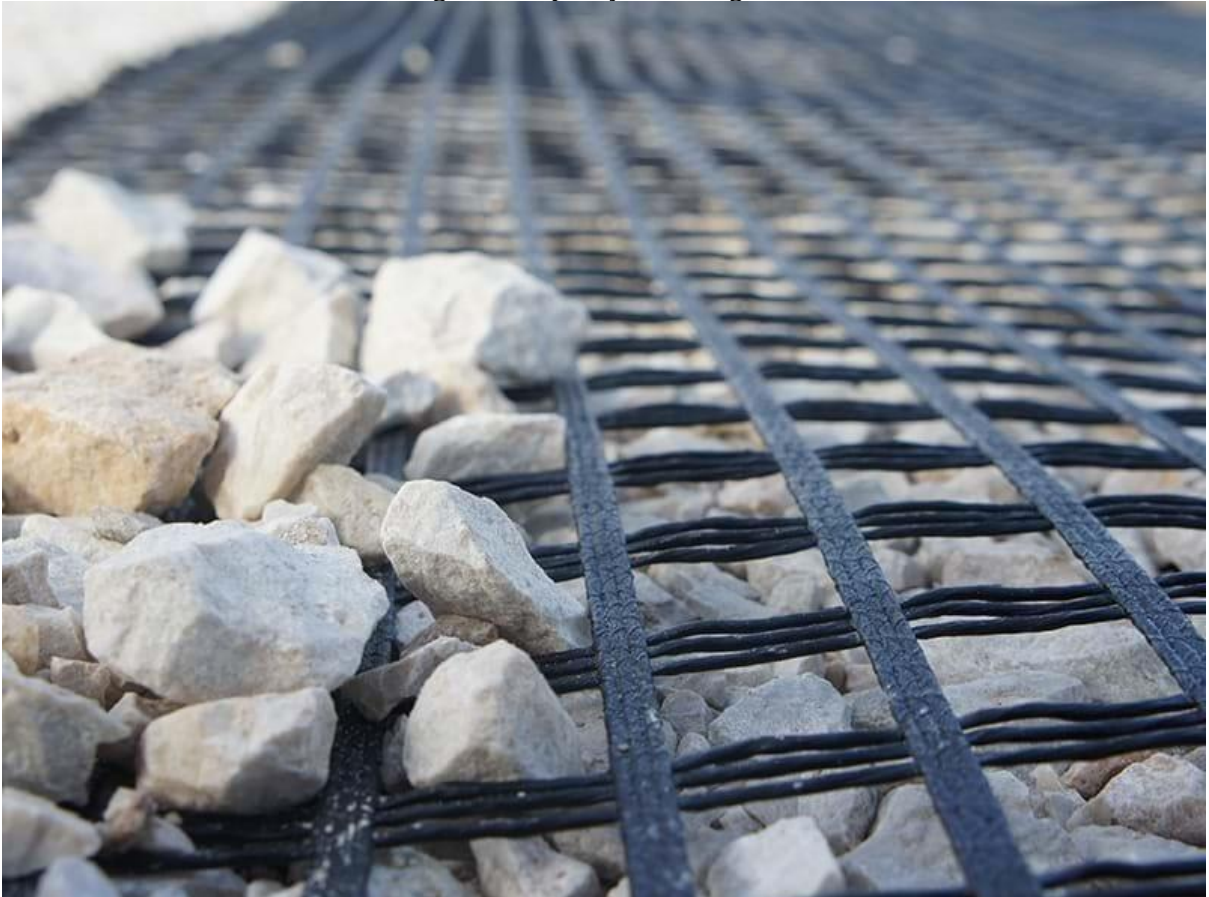
Figura 6 – Aplicação de Geogrelha.
