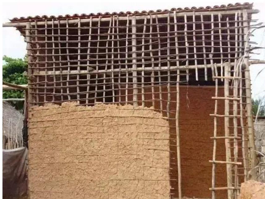
Figura 2 - Casa de taipa em processo de construção.
