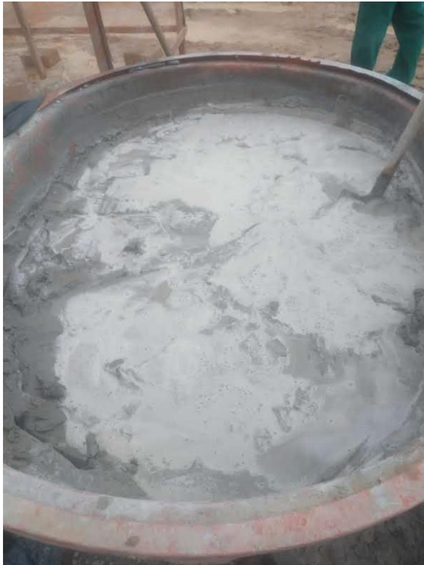
Figura 13: Argamassa Estabilizada, armazenada no canteiro de obras.
