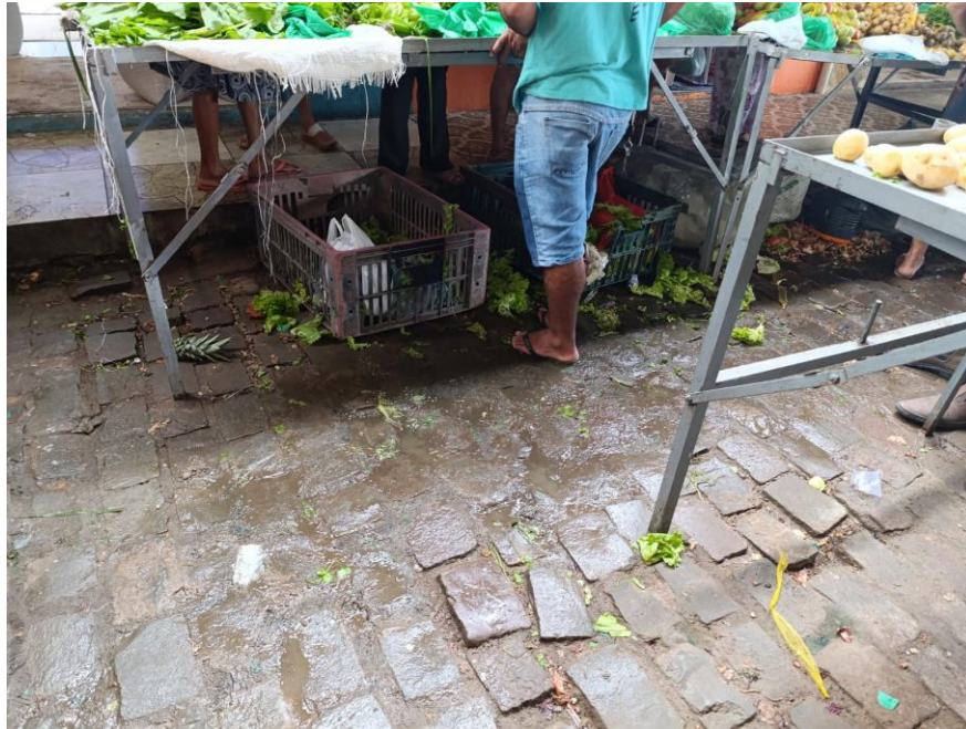
Figura 08 – Falta de higiene no Mercado Rosendo Ribeiro.
