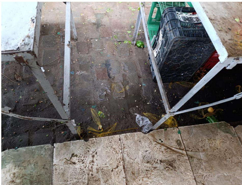
Figura 06 – Desnível existente dentro do Mercado Rosendo Ribeiro.
