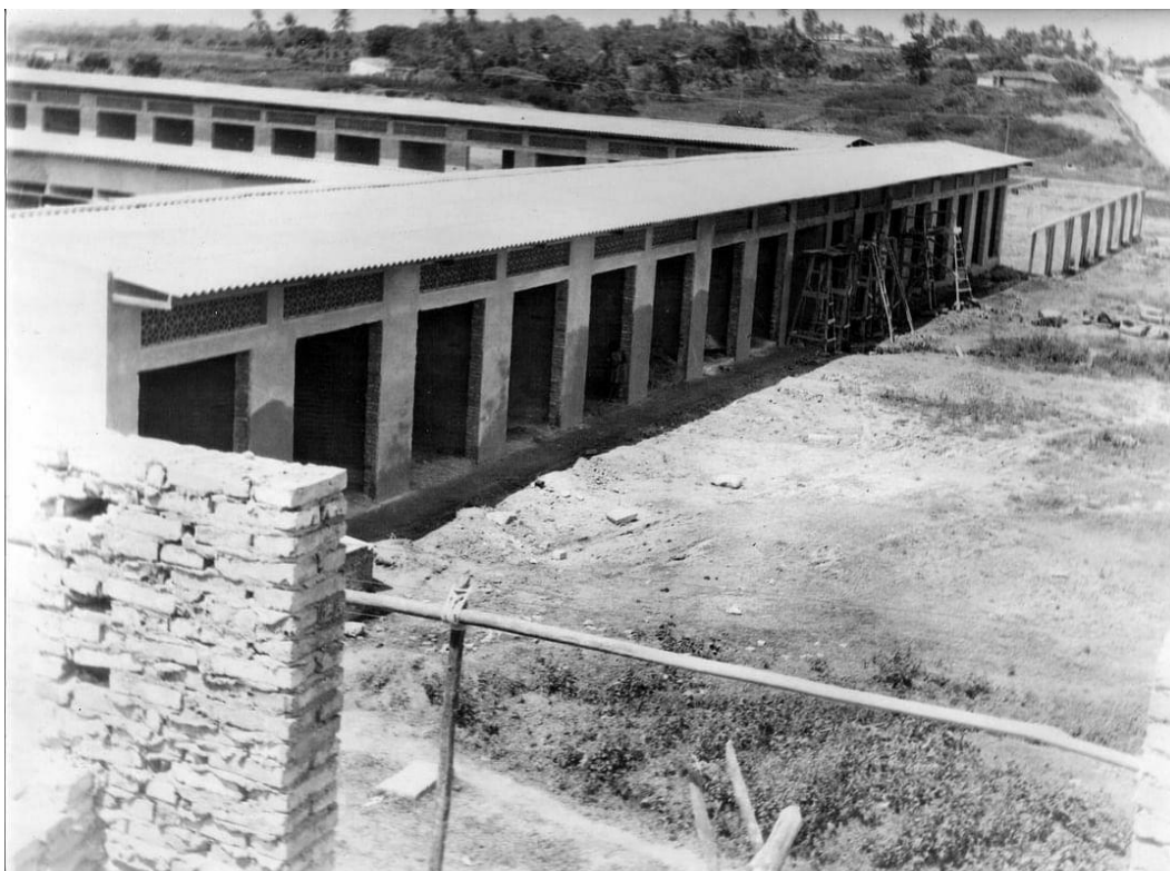
Figura 04 – Construção do mercado Rosendo Ribeiro em 1964.
