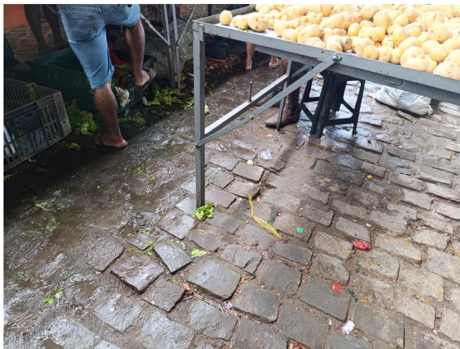
Figura 09 – Falta de higiene no Mercado Rosendo Ribeiro.
