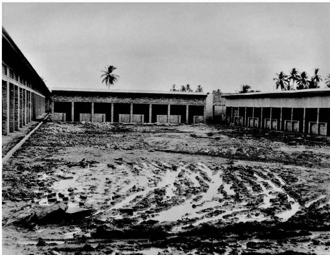
Figura 03 – Construção do mercado Rosendo Ribeiro em 1964.
