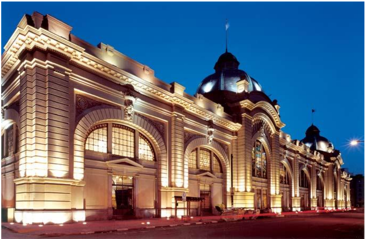
Figura 17 – Fachada externa do Mercado Municipal de São Paulo.
