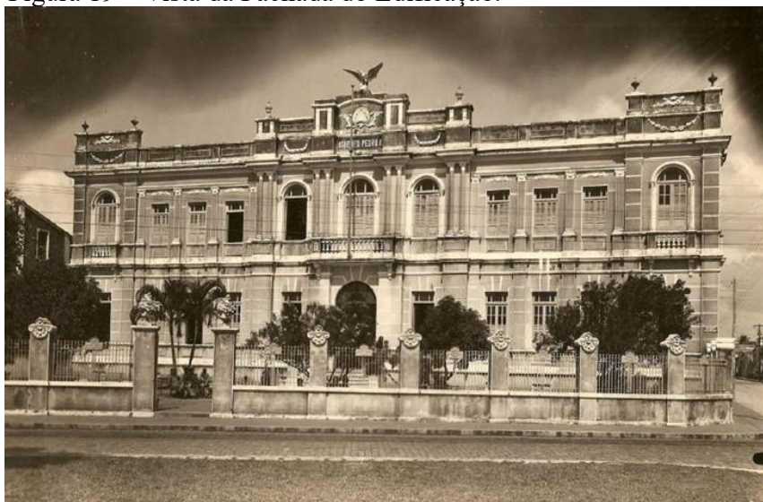
Figura 19 – Vista da Fachada do Edifício.
