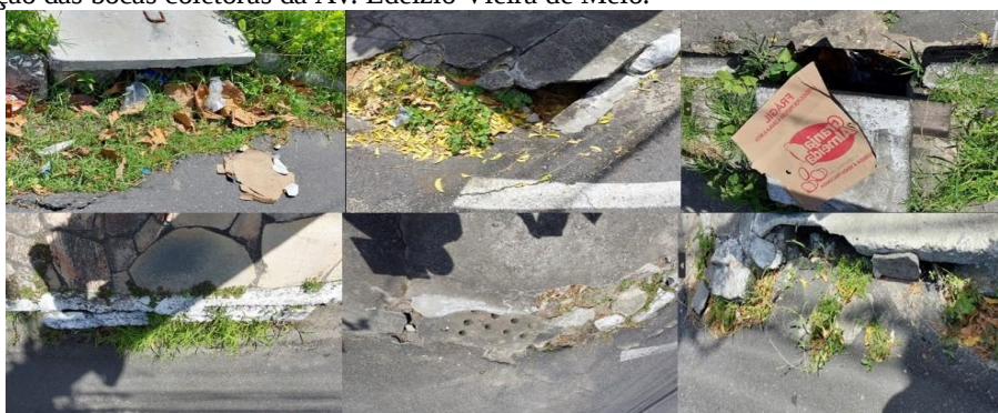
Figura 04. Situação das bocas coletoras da Av. Edélzio Vieira de Melo.
