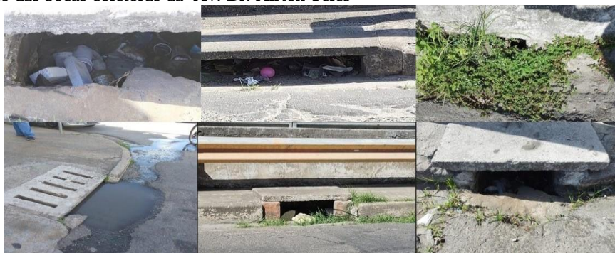
Figura 06. Situação das bocas coletoras da Av. Dr. Airton Teles
