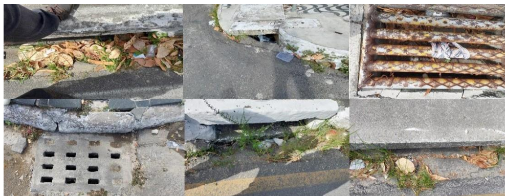
Figura 05. Situação das bocas coletoras da Av. Gonçalo Rollemberg Leite.
