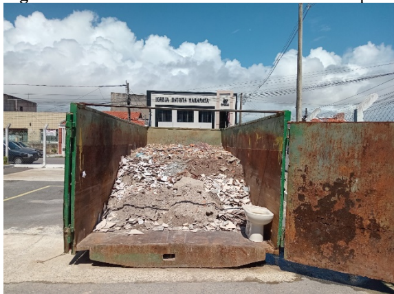
Figura 11: Caixa coletora sem cobertura no Ecoponto 06
