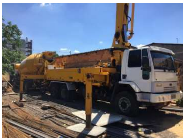
Figura 6 – Acoplamento entre caminhão betoneira e autobomba de concreto.
