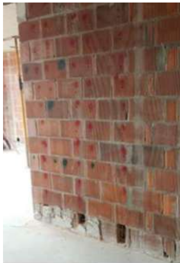
Figura 8 – Alvenaria com graute.
