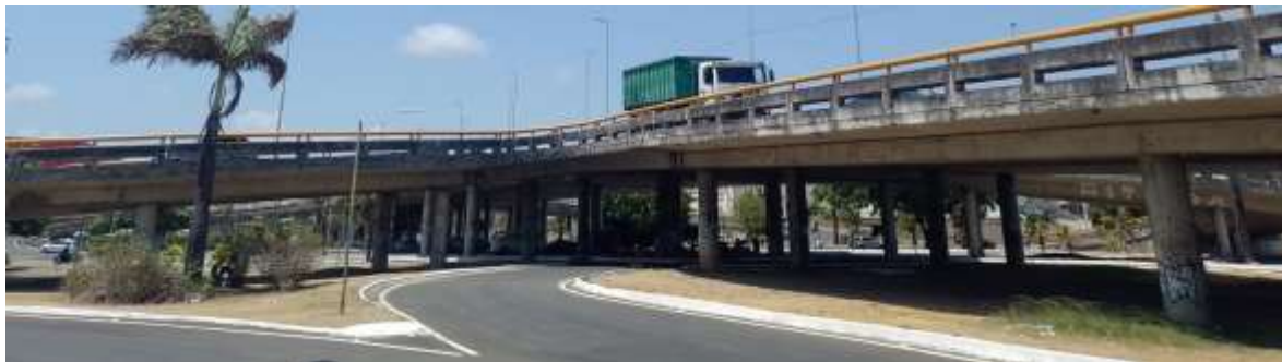
Figura 10 – Obra de arte especial (Viaduto do DIA, Aracaju-SE) em Concreto Armado.
