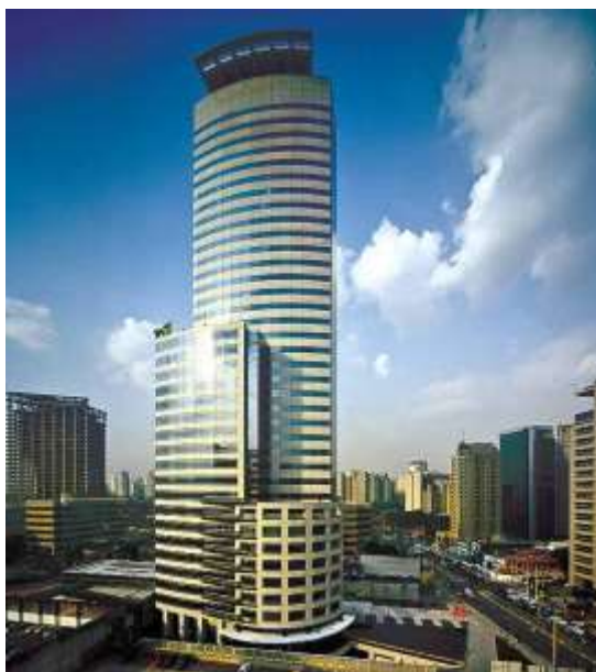
Figura 5 – Edifício E-TOWER em São Paulo.
