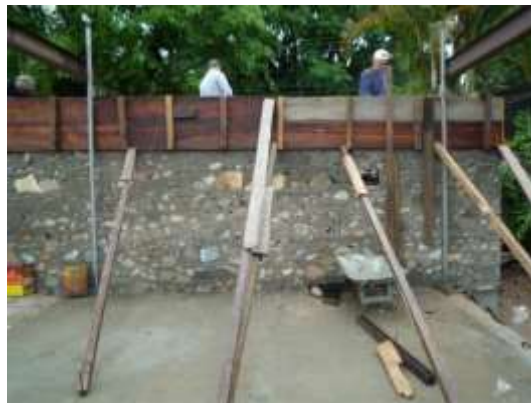
Figura 3 – Parede em concreto ciclópico.
