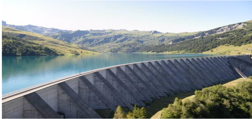
Figura 4 - Barragem de concreto com contrafortes
