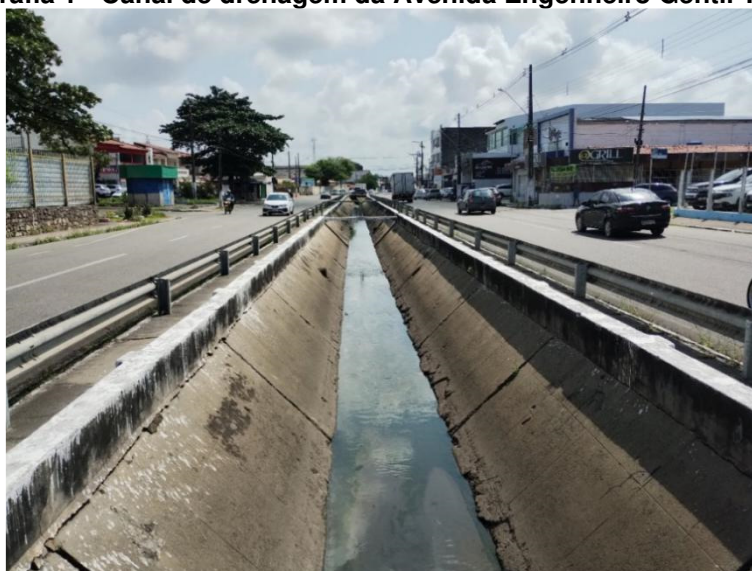
Fotografia 1 - Canal de drenagem da Avenida Engenheiro Gentil Tavares
