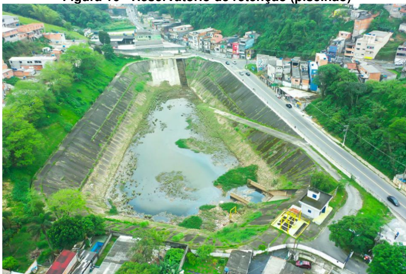
Figura 16 - Reservatório de retenção (piscinão)
