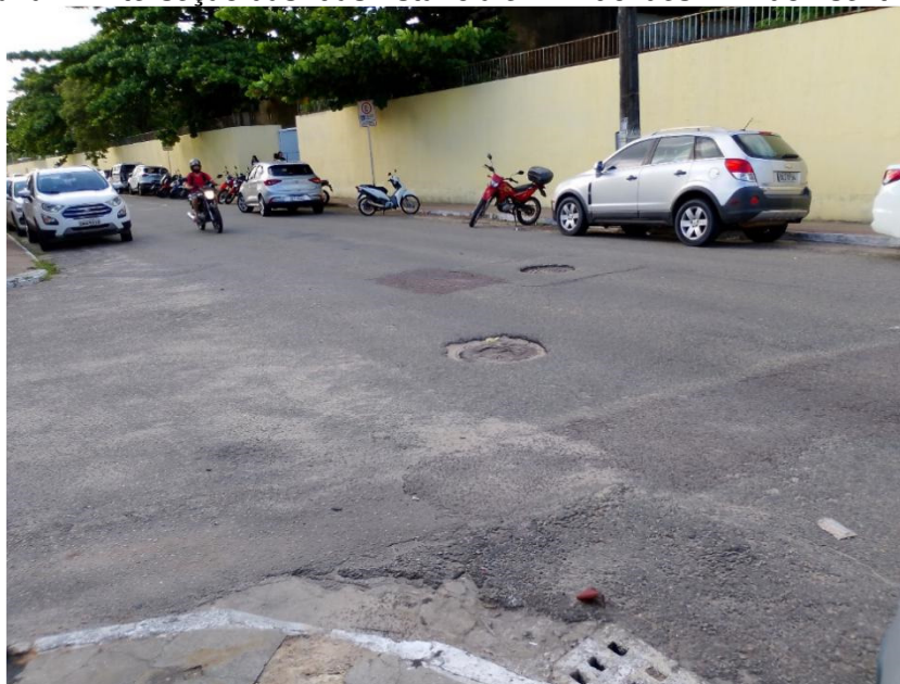
Fotografia 4 - Interseção das ruas Estância e Pr. Euclides Arlindo - sentido oeste
