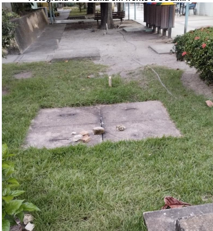
Fotografia 16 - Caixa em frente à COLIMA
