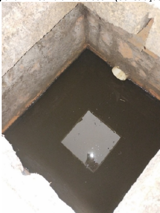
Fotografia 14 - Caixa 04 do bloco V (Construção Civil)
