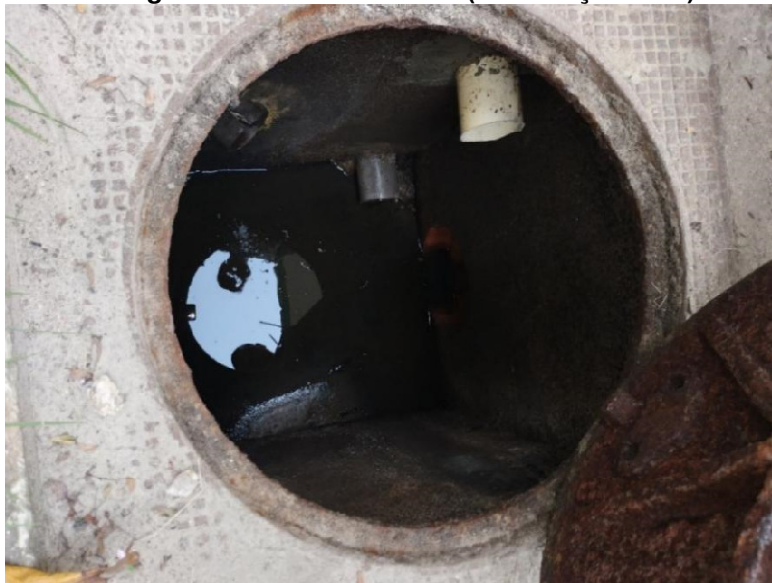
Fotografia 10 - PV do bloco V (Construção Civil)
