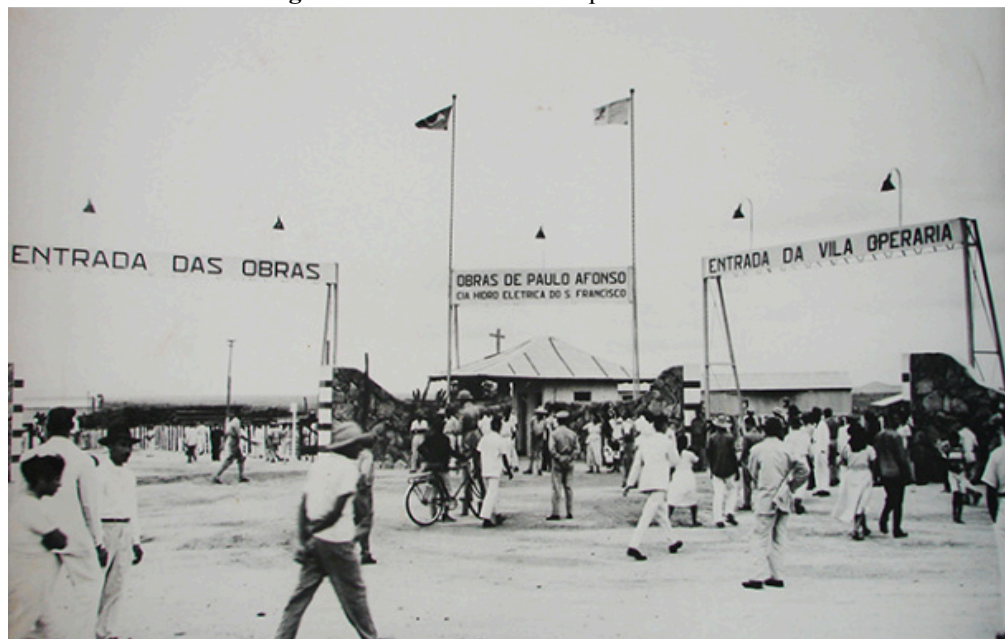
Figura 16 - Entrada da Vila Operária e Obras.
