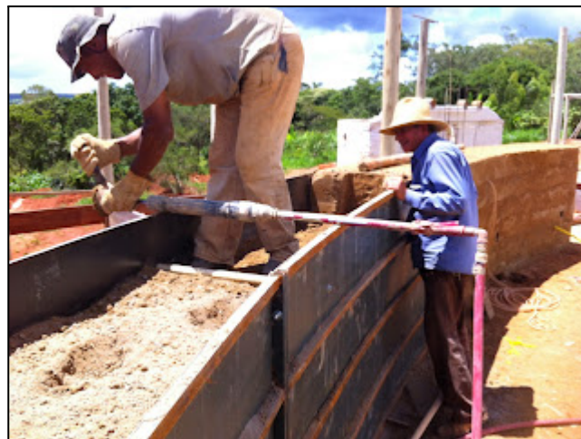
Figura 8: Processo de preenchimento da forma com a terra
