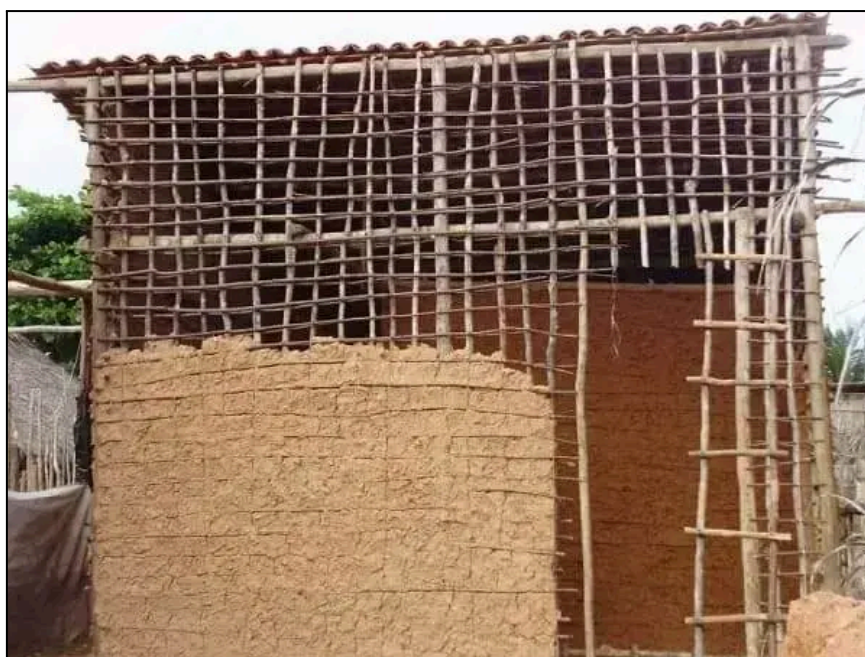
Figura 7: Foto da estrutura da taipa de mão sendo preenchida com barro
