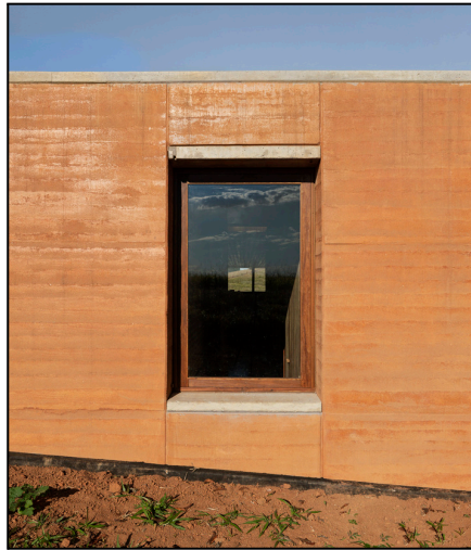
Figura 14: Parede de taipa da Casa em Cunha
