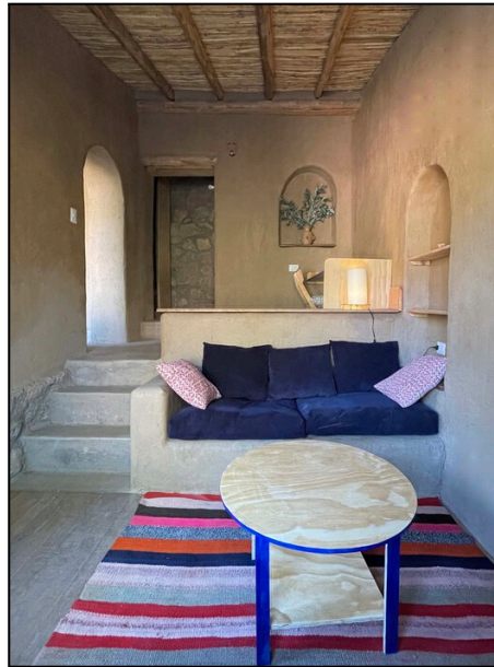
Figura 26: Vista que expõem o telhado e as paredes de adobe
