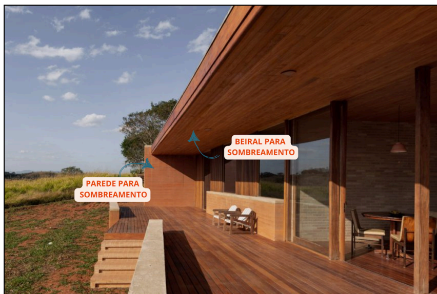
Figura 15: Paredes e beiral avançando limites da edificação
