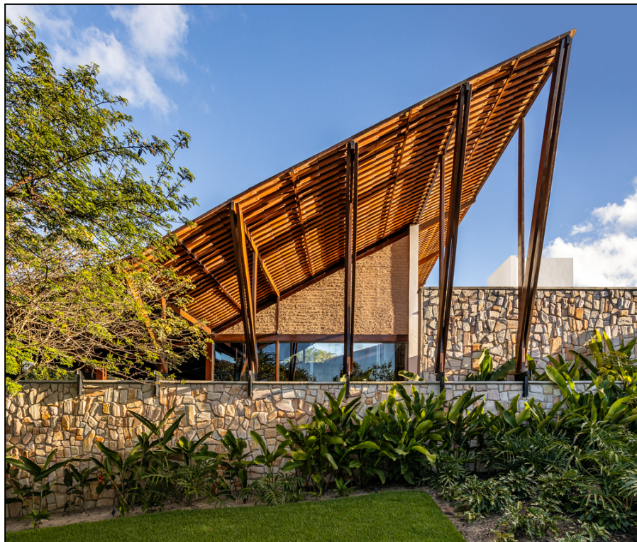
Figura 18: Vista frontal da Casa discreta
