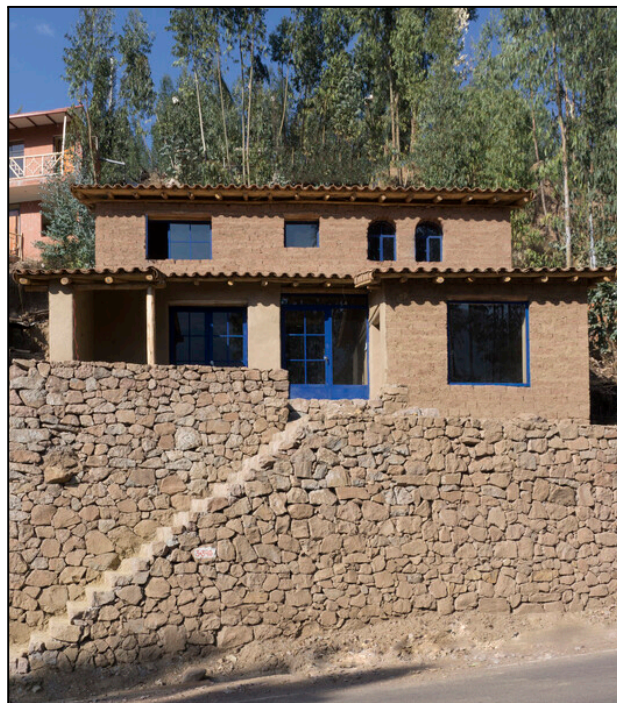
Figura 25: Vista frontal da casa Martha
