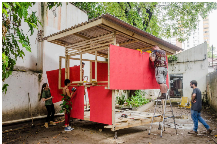
Figura 32: Cubito, protótipo de arquitetura modular, híbrida e desmontável.
