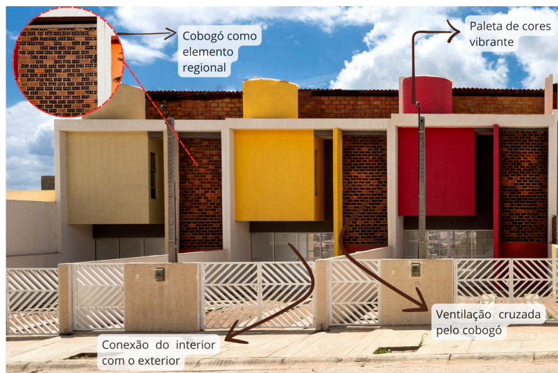
Figura 15: Fachadas Sobrados Novo Jardim.
