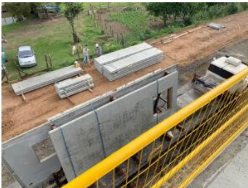
Figura 28: Módulos de paredes de concreto transportados para a obra para serem montados.
