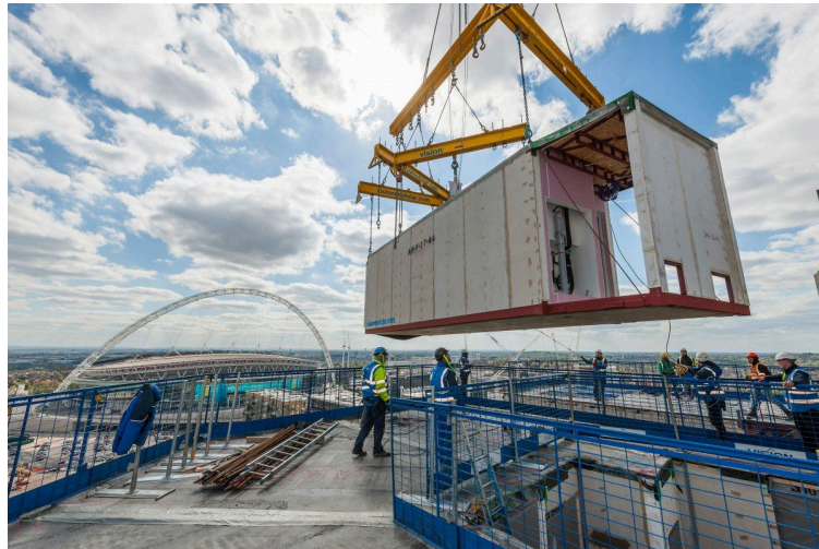
Figura 29: Montagem de módulo volumétrico na obra.
