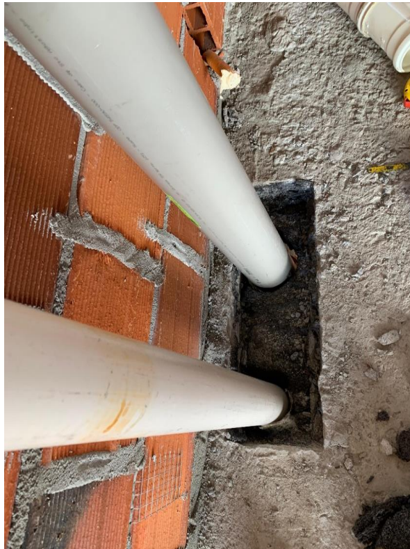
Figura 40 — Passagem de espuma de polietileno expandido com parte superior removida
