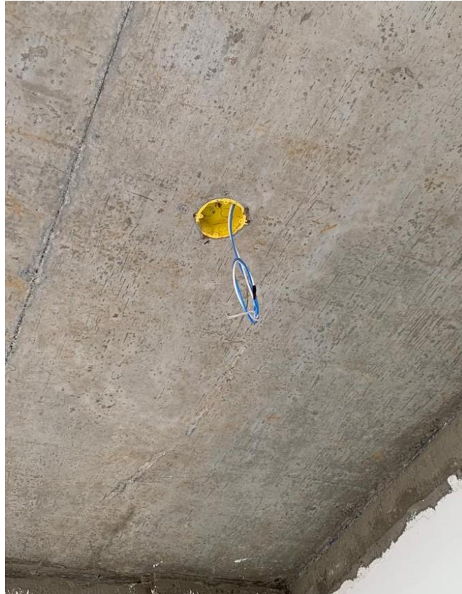
Figura 6 — Caixa PVC de ponto de luz embutida na estrutura
