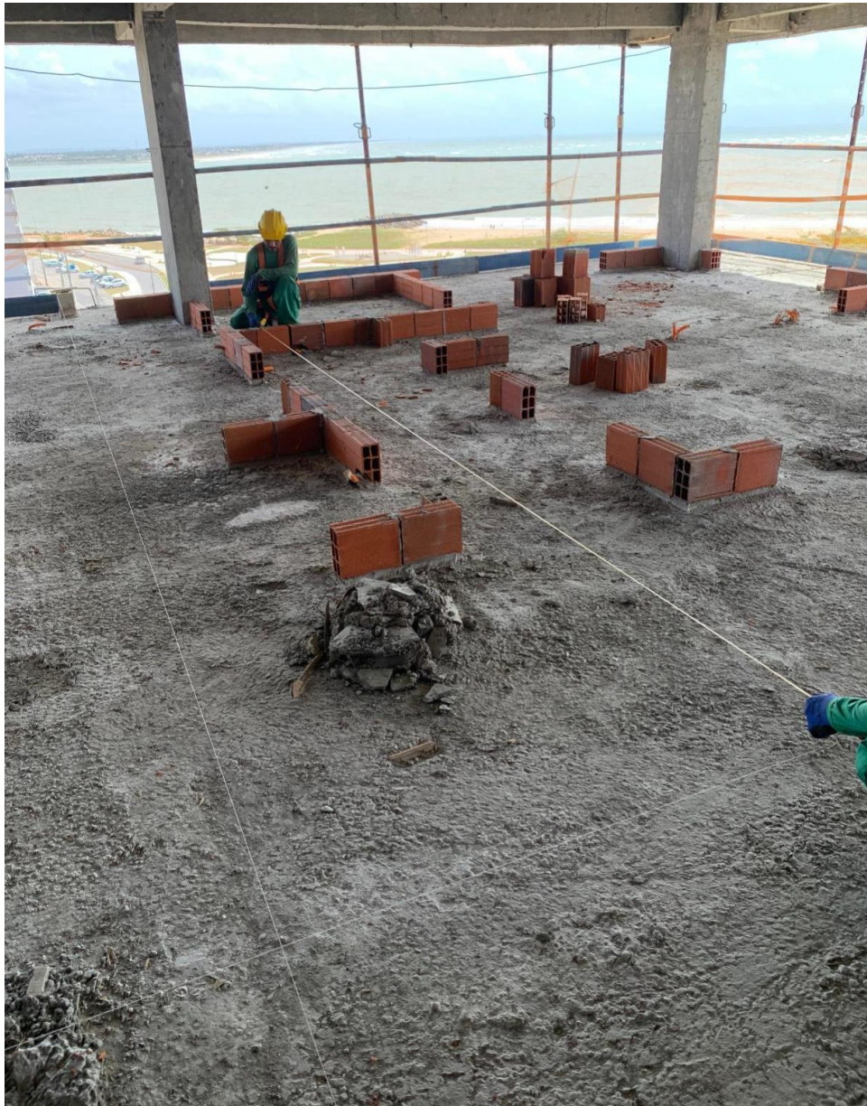
Figura 16 — Execução da marcação das alvenarias pelas linhas de eixo
