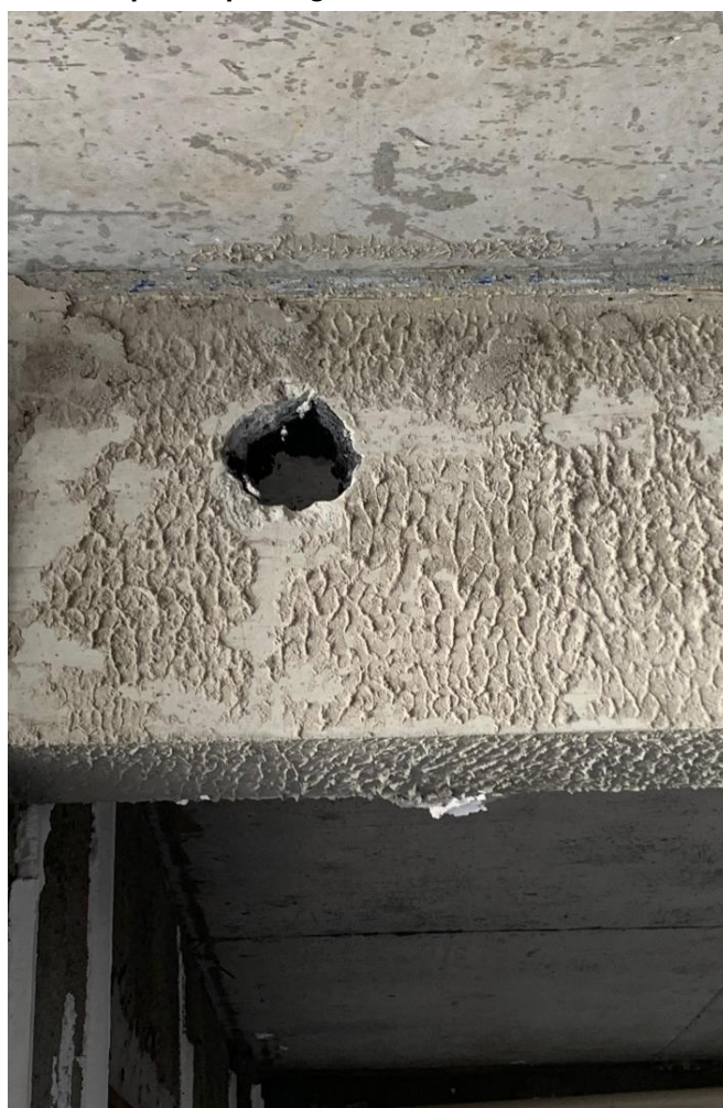
Figura 4 — Exemplo de passagem hidráulica em elemento estrutural
