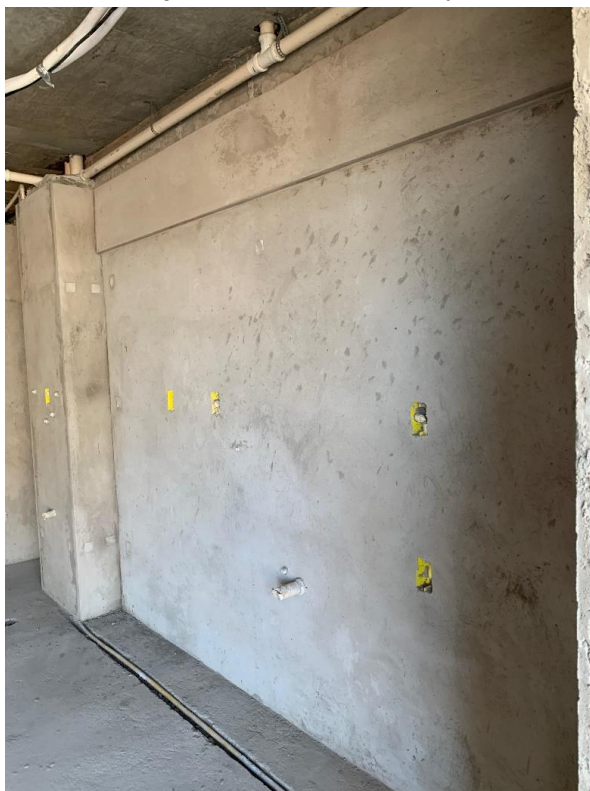
Figura 3 — Exemplo de aresta saliente (“dente de viga”)
