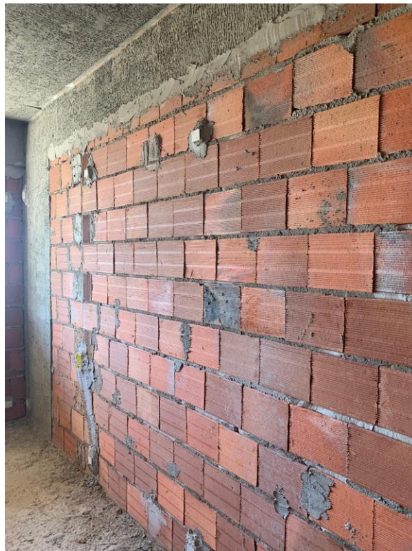
Figura 18 — Lado da parede alinha com face da viga
