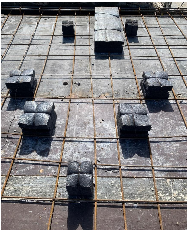
Figura 39 — Passagens em espuma de polietileno expandido locadas na forma da laje
