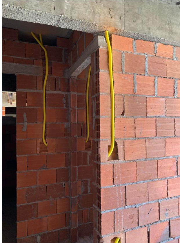
Figura 50 — Descida na alvenaria de tubulação elétrica que passa pela laje do teto
