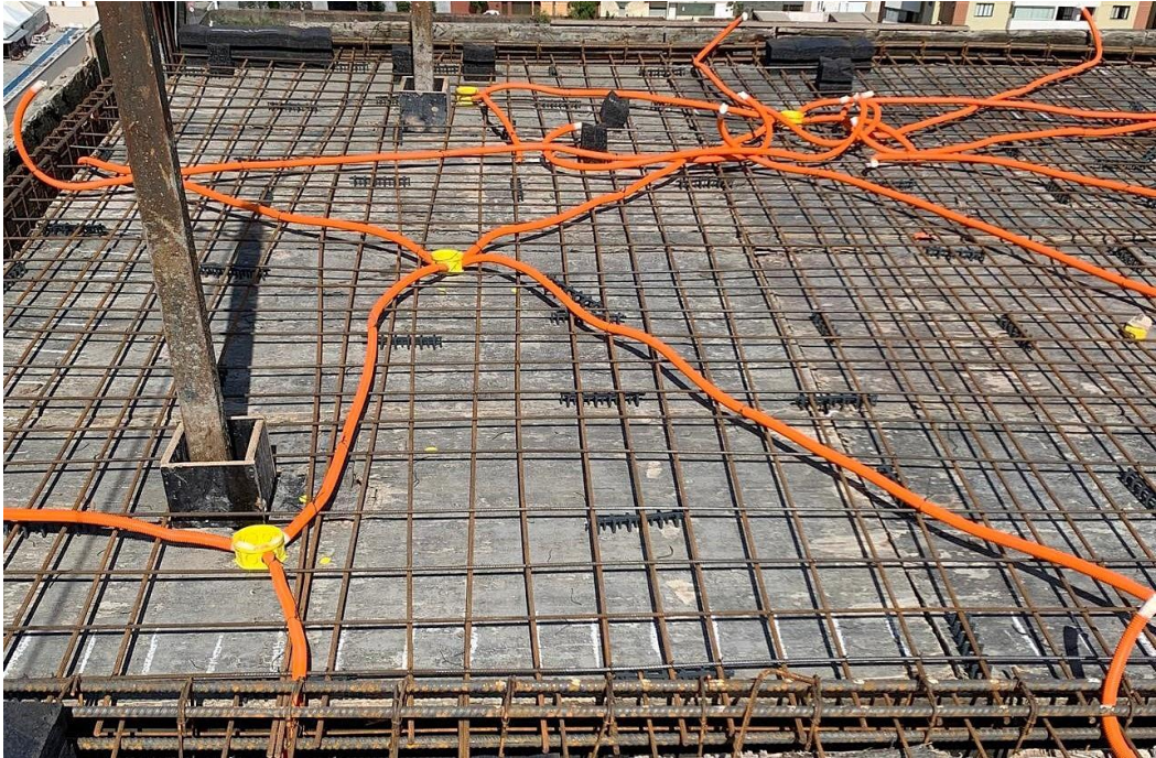
Figura 51 — Tubulações elétricas embutidas na estrutura
