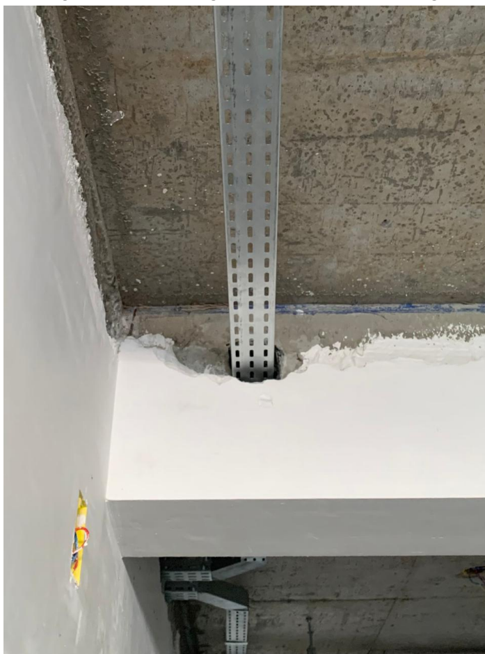
Figura 46 — Passagem de eletrocalha em viga
