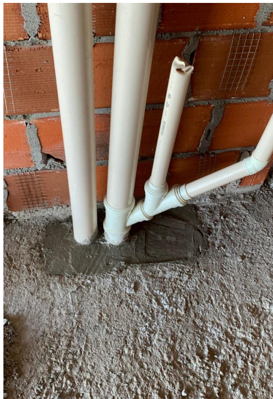
Figura 41 — Passagem de espuma de polietileno expandido depois de grauteada
