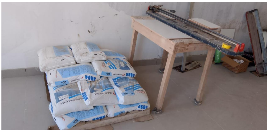
Figura 6 – Material disposto no local de utilização.
