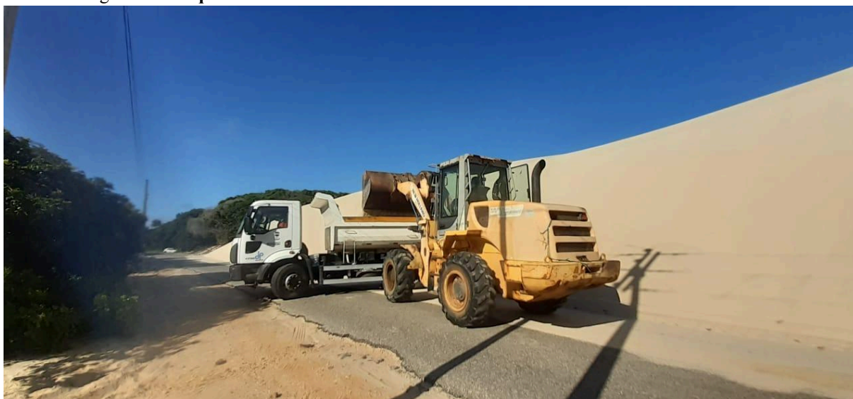
Figura 22: Máquinas retirando excesso de areia das dunas móveis da Praia do Saco/SE
