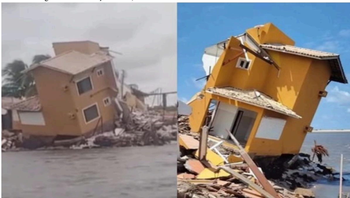
Figura 01 - O avanço do mar, ocasiona em afundamentos de casas na Praia do Saco.
