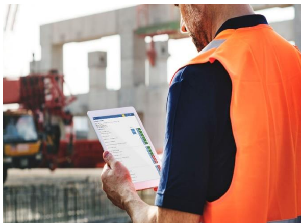
Figura 9 – Preenchimento da FVS
