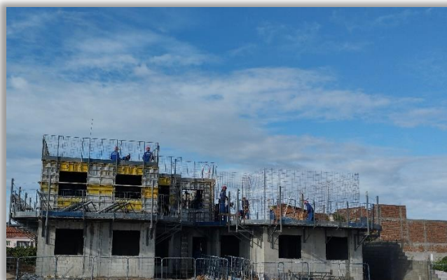
Figura 1 – Execução do SEPCA
