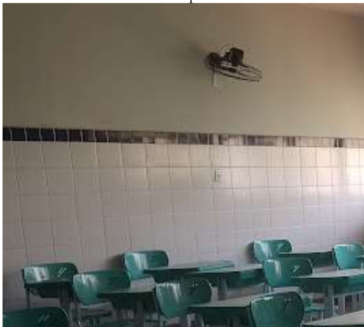
Figura 22: Revestimento cerâmico nas paredes das salas de aula do Bloco 02
