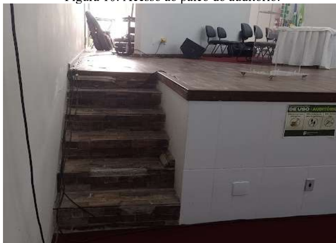
Figura 10: Acesso ao palco do auditório.
