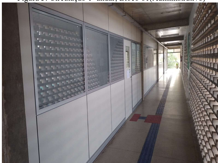
Figura 5: Circulação 1º andar, Bloco 01(Administrativo)
