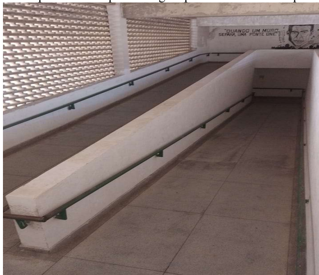
Figura 11: Rampa acessível que interliga o pavimento térreo ao primeiro andar
