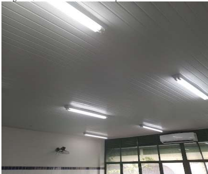
Figura 23: Forro de PVC e iluminação artificial das salas de aula
