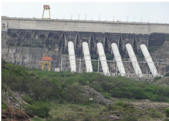
Figura 17 – Usina Hidrelétrica de Xingó (SE/AL)
