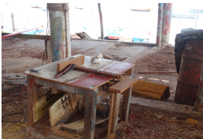
Figura 10 – Estaleiro com instrumento elétrico em Piaçabuçu (AL)
