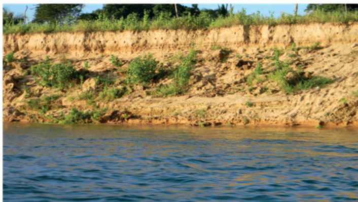
Figura 31 – Erosão na margem alagoana do rio São Francisco
