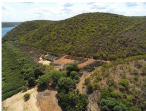
Figura 44 – Vista geral da RPPN Mato da Onça (AL) 264
