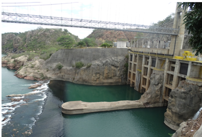
Figura 20 – Vista parcial do Complexo Hidrelétrico de Paulo Afonso (BA)
