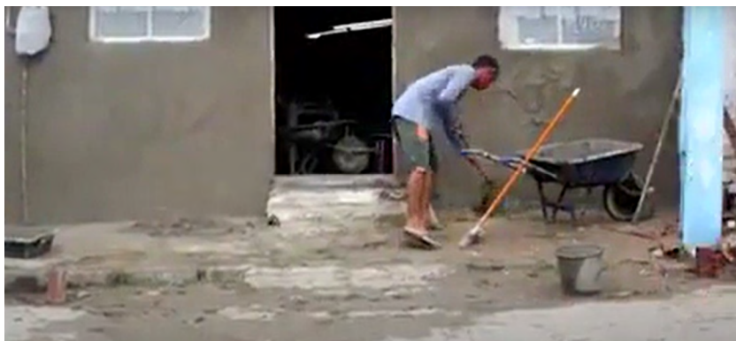
Figura 68: Homem trabalha em uma obra na comunidade Caranguejo Cabaires.
